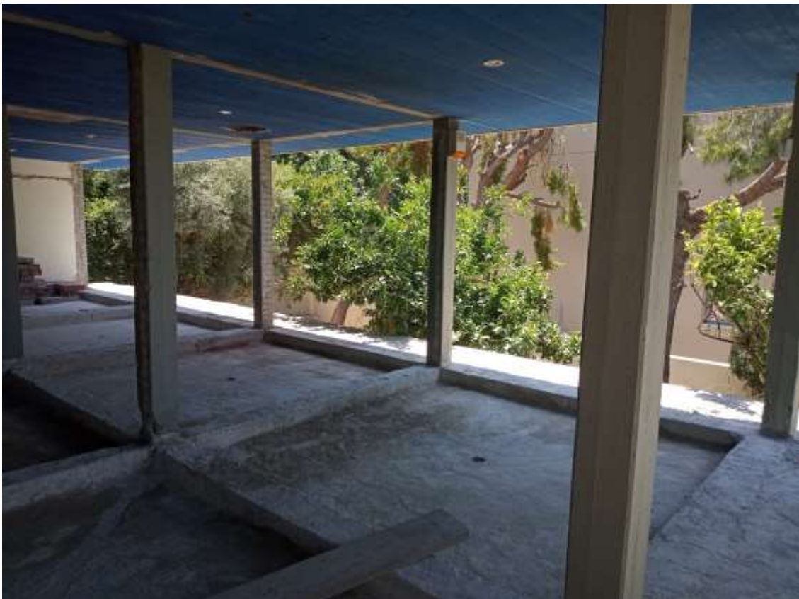
Εικόνα 2: Αποκάλυψη των ανεστραμμένων δοκών οροφής ισογείου
