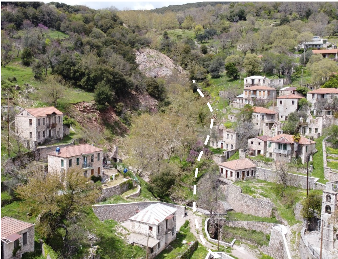
Σχήμα 05: Το κτήριο στο κάτω μέρος της φωτογραφίας. Διακρίνεται η σχέση του με το βουνό και το ρέμα
