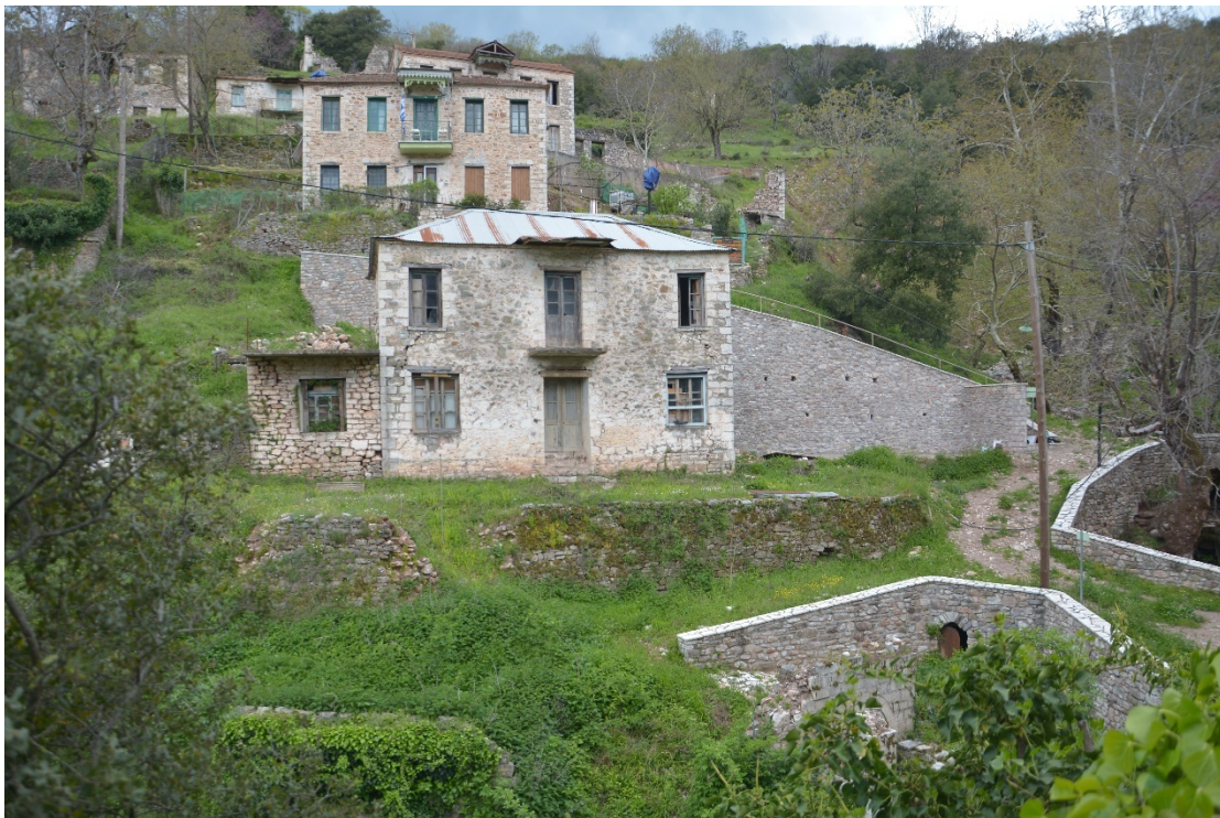
Σχήμα 02: Το κτήριο μελέτης (δυτική όψη) και ο περιβάλλον χώρος αυτού.
