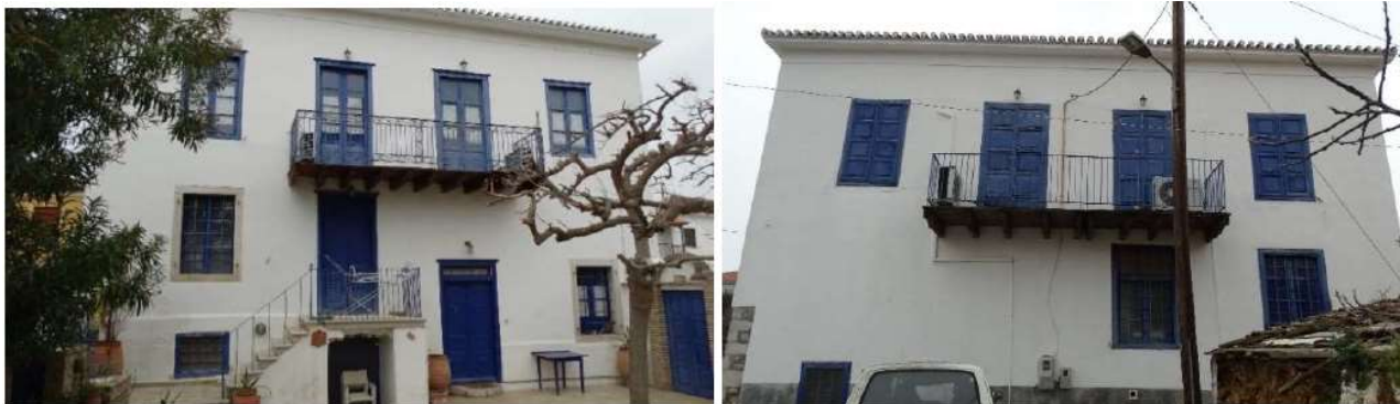
Εικόνα 9: Κύριες (νότια αριστερά και βόρεια δεξιά) όψεις του κτιρίου.
