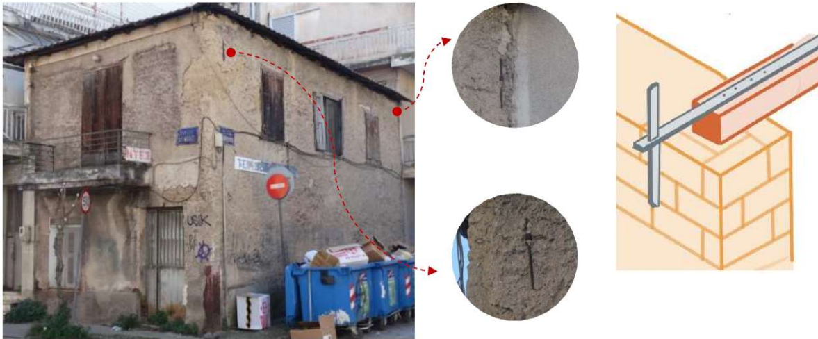
Εικόνα 6: Αριστερά: Κατοικία με μεταλλικά στοιχεία αγκύρωσης στις όψεις της, στην προσφυγική συνοικία της Πάτρας. Δεξιά: Σχηματική απεικόνιση πιθανής διάταξης μεταλλικής αγκύρωσης ξύλινης δοκού.
