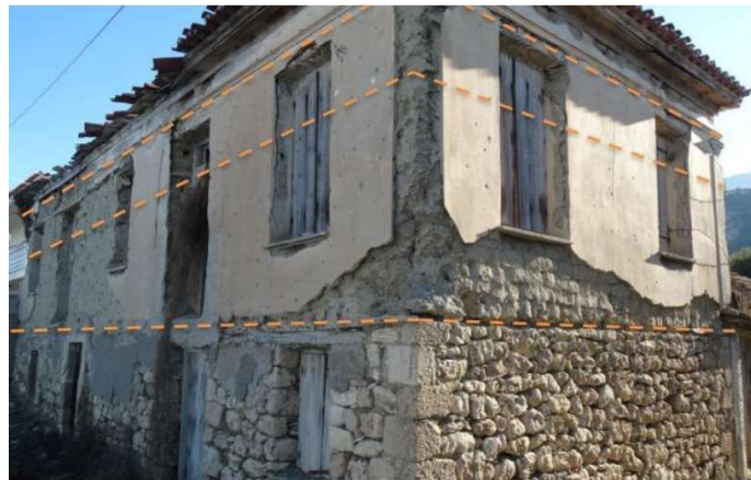
Εικόνα 5: Στάθμες ξυλοδεσιών και οριζόντιων ενισχύσεων (ενδιάμεση στάθμη) στην περιοχή Λυκοποριά δήμου Ξυλοκάστρου – Ευρωστίνης.
