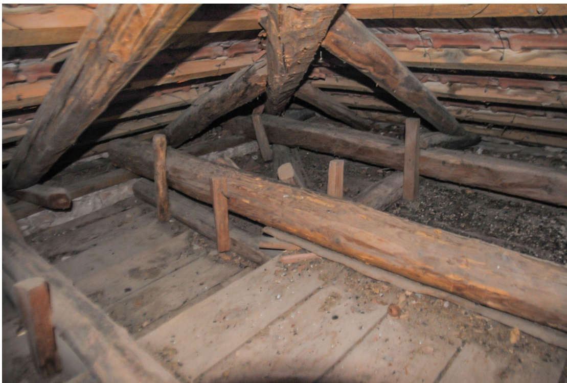
Σχήμα 8: Ανάρτηση οροφής δωματίου Α.4.
