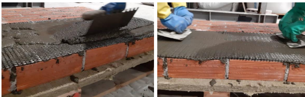
Σχήμα 4.2 Διαδικασία τοποθέτηση της στρώσης ανθρακο-πλέγματος
