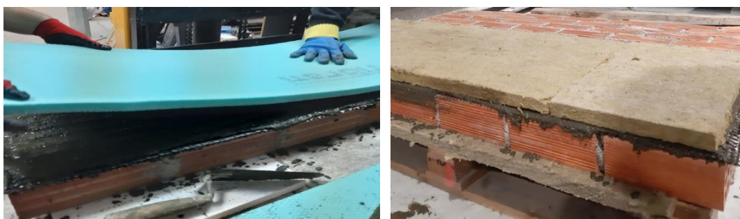
Σχήμα 4.3 Τοποθέτηση θερμομονωτικών πλακών εξηλασμένης πολυστερίνης/πετροβάμβακα
