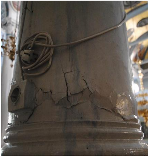
Σχήμα 32: Αποσάθρωση ξύλινης επένδυσης κίωνων
