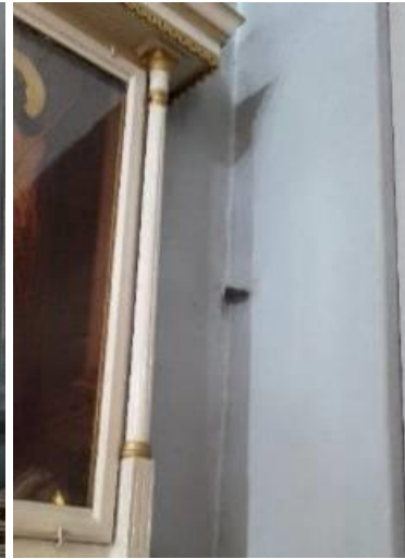
Σχήμα 34: Κοπή μεταλλικών λαμών - ελκυστήρων (βόρειο, νότιο κλίτος)
