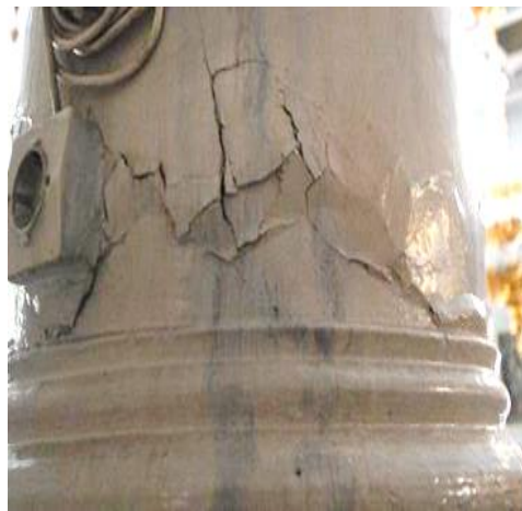
Σχήμα 45: Αποσάθρωση ξύλινης επένδυσης
