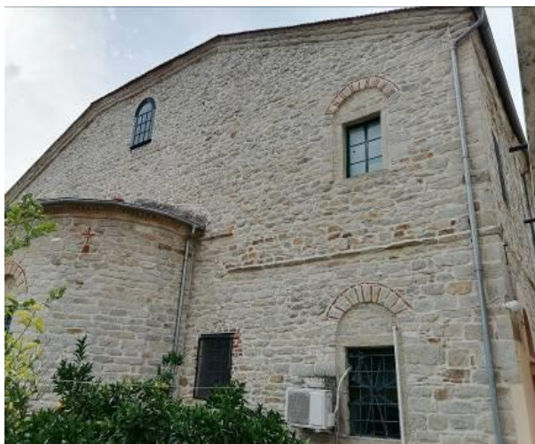
Σχήμα 9: Φέρουσα τοιχοποιία (ανατολική όψη).
