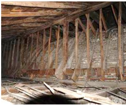
Σχήμα 13: Κεντρικοί ορθοστάτες - Θολωτή κατασκευή.
