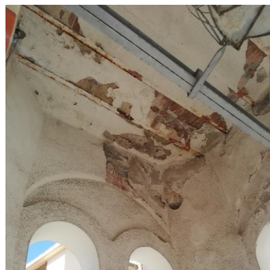
Σχήμα 47: Αποσάθρωση πατωμάτων κωδωνοστασίου
