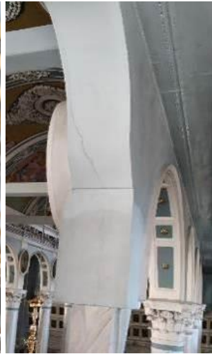
Σχήμα 33: Τριχοειδείς ρηγματώσεις στην ξύλινη επένδυση
