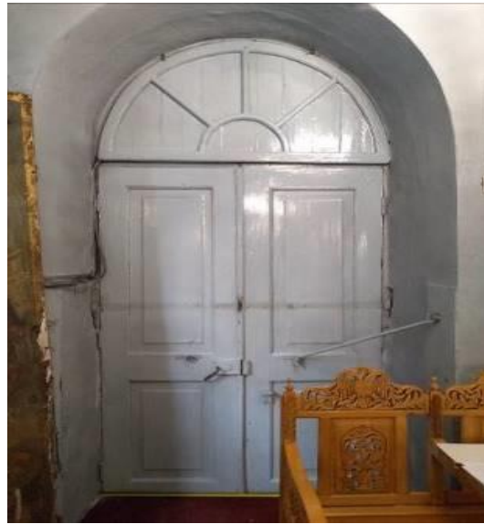
Σχήμα 18: Εσωτερική ξύλινη θύρα α' στάθμης
