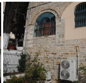
Σχήμα 31: Τοποθέτηση Η/Μ εξοπλισμού στη νότια όψη
