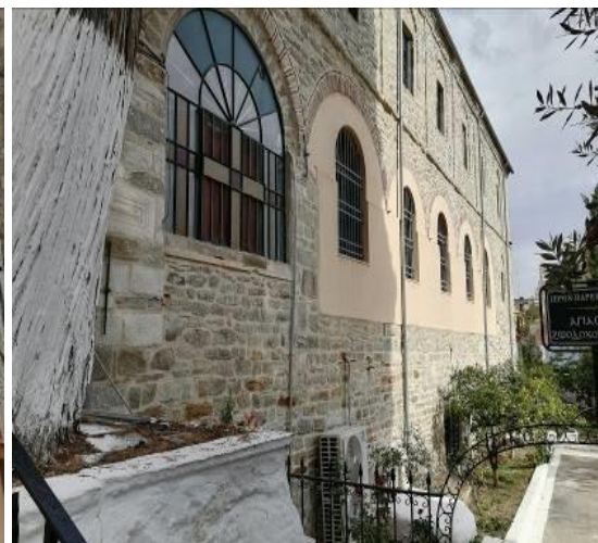
Σχήμα 10: Πεσσοί με τοξωτά ανοίγματα και πλήρωση από αργολιθοδομή (νότια όψη).
