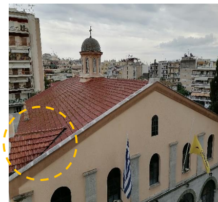
Σχήμα 46: Δικλινής στέγη Ναού
