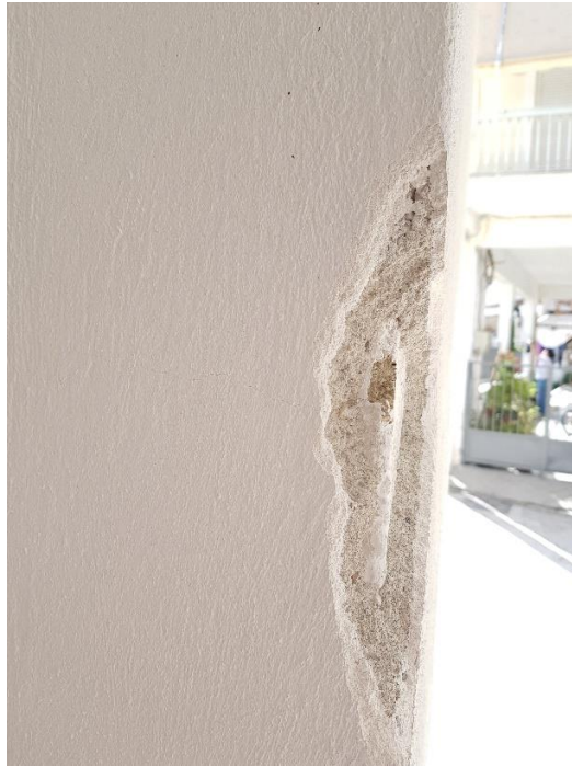
Εικόνα 16: Υποστυλώμα Ισογείου K9.
