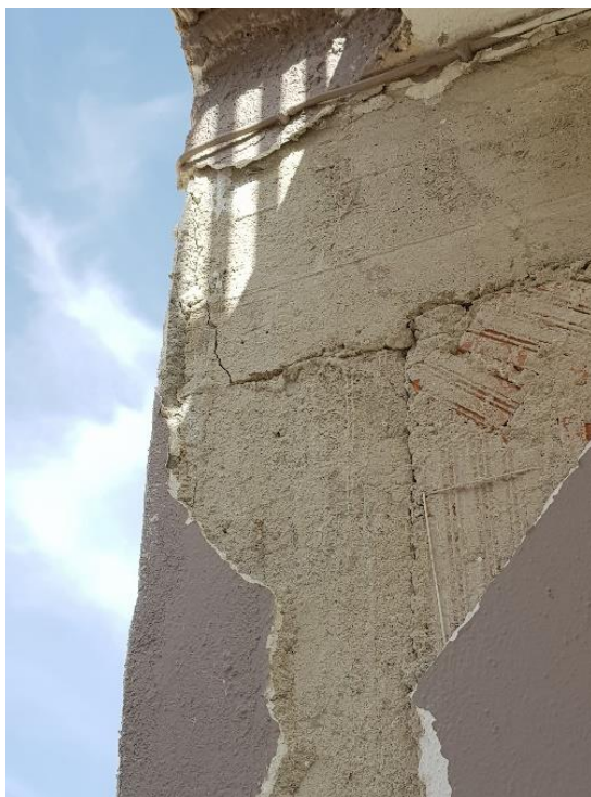
Εικόνα 14: Υποστόλωμα Ισογείου Κ11.
