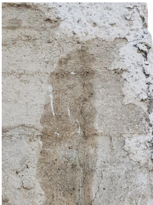
Εικόνα 15: Υποστόλωμα Ισογείου Κ12.
