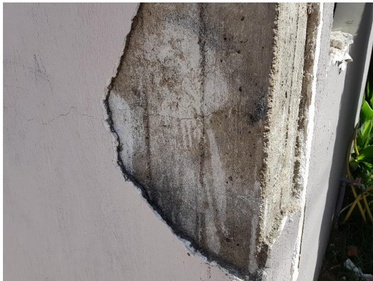
Εικόνα 13: Υποστύλωμα Ισογείου K11.
