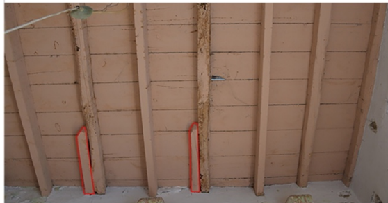
Παράλληλα στοιχεία με τα δοκάρια του πατώματος Σύνδεση δοκαριών με ξυλοδεσιές
