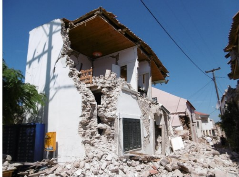
Σχήμα 8.2.: Αποκόλληση τοίχων και γωνιών.
