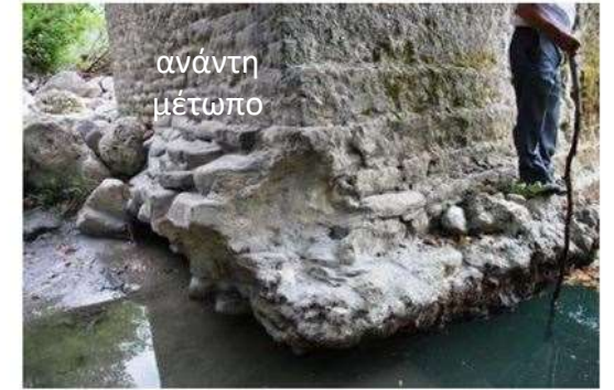
Σχέδιο της μελέτης επισκευής (2005) και υποσκαφή θεμελίου (Αρχείο ΕΜΠ)
