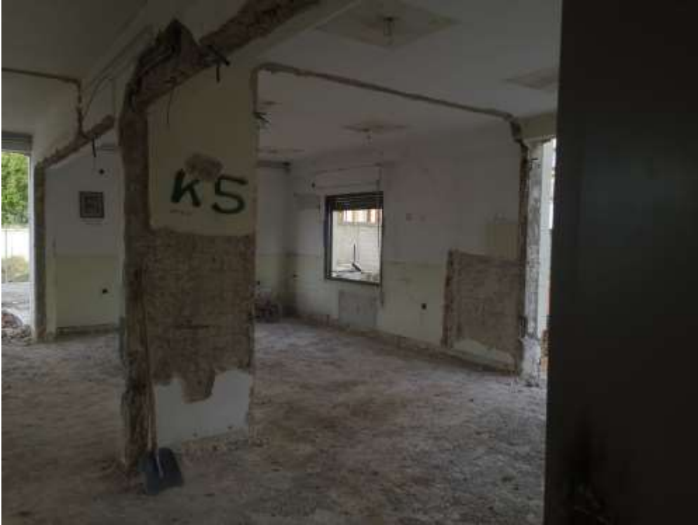
Εικόνα 1 Οπλισμός υποστυλώματος K5
