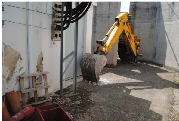
ΦΩΤ.01. Εργασίες δειγματοληψίας 1 ου ερευνητικού φρέατος πλησίον της κολώνας στο εσωτερικό του κτίριου (αυξημένος βαθμός δυσκολίας διάνοιξης του φρέατος).
