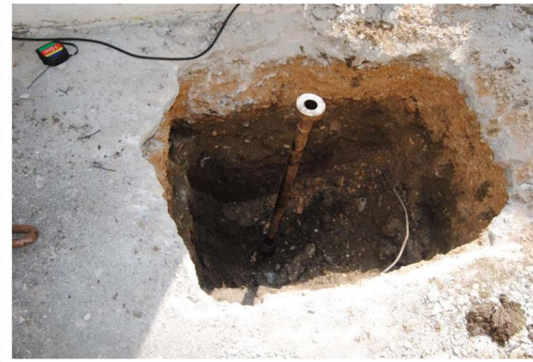
ΦΩΤ.05. Επιτόπου δοκιμές (πέρας δοκιμής) στο εσωτερικό του 1 ου φρέατος (αποτύπωση της στρωματογραφίας) με ειδικό δειγματολήπτη Shelby για την λήψη αδιατάρακτου εδαφικού δείγματος
