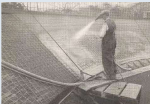
Εκτόξευση σκυροδέματος το 1919 για κατασκευή δεξαμενής νερού
