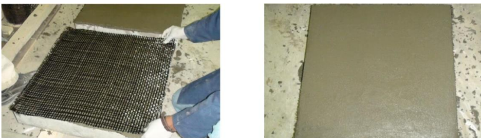
Σχήμα 3. Διαμόρφωση ενίσχυσης TRM [1]
