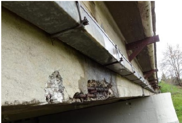
Εικόνα 2.2: Διάβρωση Οπλισμών στην Περιοχή των υδρορροών
