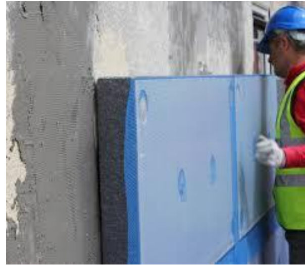
Θερμομονωτικές πλάκες (ενεργειακή αναβάθμιση)
