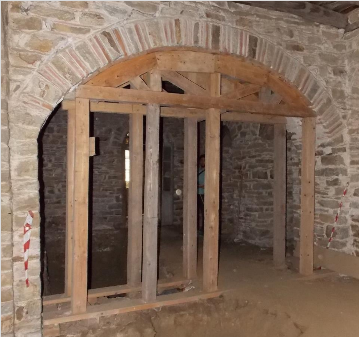
Απλή υποστύλωση χαμηλωμένου τόξου με ξύλινο ικρίωμα
