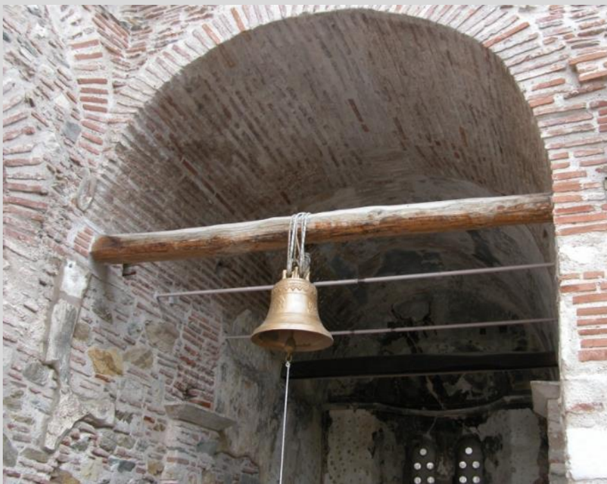
Η τοποθέτηση απλών ελκυστήρων
