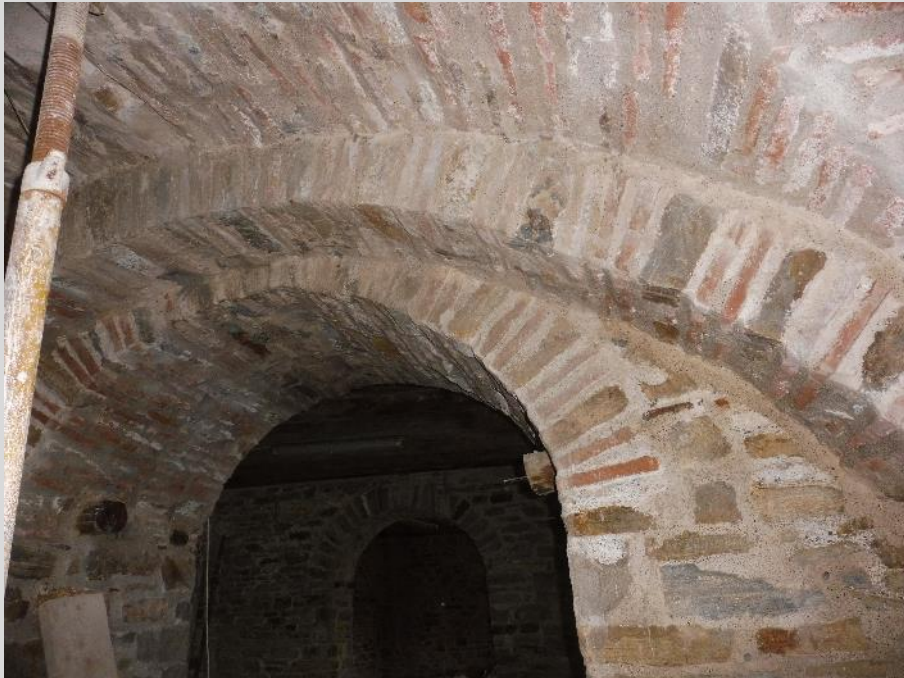
Λιθο-πλινθοσυρραφές, αναδόμηση και αρμολόγημα των εσωρραχίων
