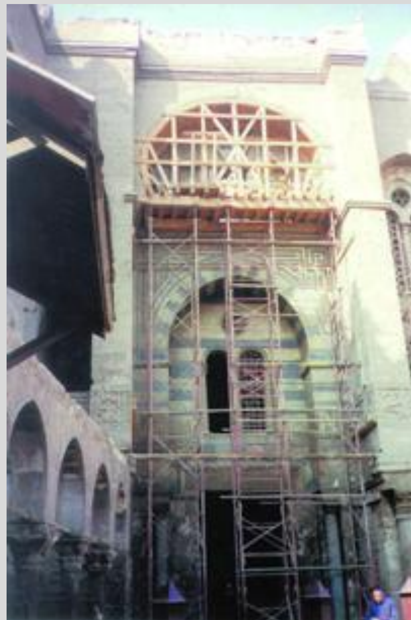
Συρραφή τόξου με άτονες ανοξειδωτες ράβδους (ρεντίκολα)
