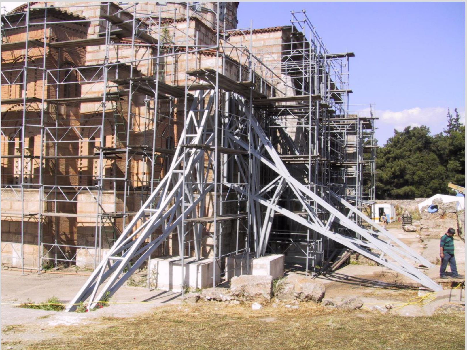
Αντιστήριξη θόλων και τοιχοποιίας
