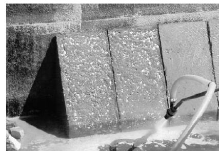
Εκτράχυνση με Αμμοβολή
