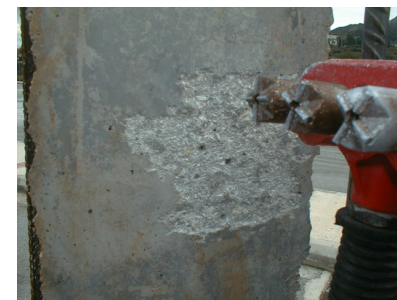
Προετοιμασία Επιφάνειας με Αεροματσάκονο
