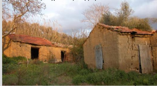
Οικίες με πλίνθινες τοιχοποιίες στη νότια Ελλάδα (Αχαΐα)
