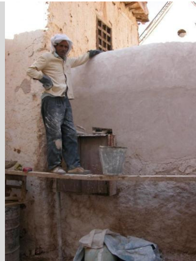
Μονή Σινά. Μαγειρείο. Ανακατασκευή επιχρισμάτων με ινοπλισμένο ασβεστοκονίαμα με βάση το χώμα και τον ασβέστη.
