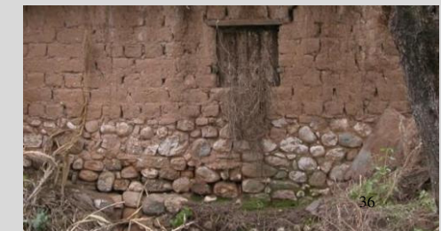
Ο μηχανισμός της διάβρωσης των τμημάτων πλίνθρινης τοιχοποιίας και δώματος
