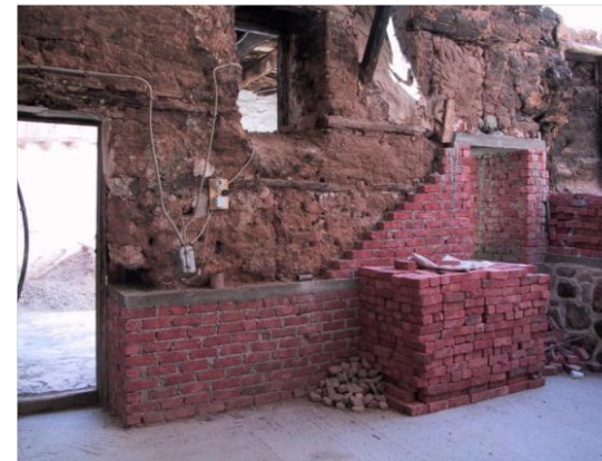
Επένδυση της φθαρμένης ιστορικής τοιχοποιίας από πλίνθες με νέο τοίχο από συμπαγείς οπτόπλινθους, προκειμένου να στερεωθούν σε αυτόν τα δίκτυα Η/Μ εγκαταστάσεων
