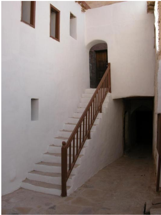
Μονή Σινά. Μαγειρείο. Ανακατασκευή επιχρισμάτων με ινοπλισμένο ασβεστοκονίαμα με βάση το χώμα και τον ασβέστη.
