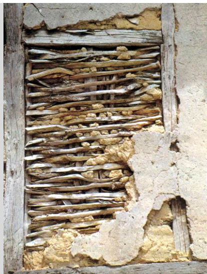
Βέροια, ξυλόπηκτος τοίχος με σκελετό από ξύλο, πλήρωση με «πλοκαριά» και επίχριση με χώμα
