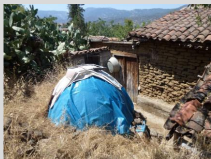
Οικία με πλίνθινη τοιχοποιία σε θεμέλιο από τοιχοποιία. Ευρύχου, Κύπρος (ανέγερση περί το 1926 – κατεδάφιση 2010)
