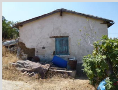
Οικία με πλίνθινη τοιχοποιία σε θεμέλιο από τοιχοποιία. Ευρύχου, Κύπρος (ανέγερση περί το 1926 – κατεδάφιση 2010)
