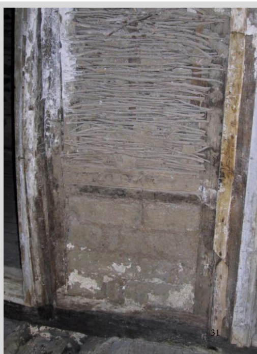
Ξυλόπηκτος τοίχος με γέμισμα από πλίνθρες και πλοκαριά
