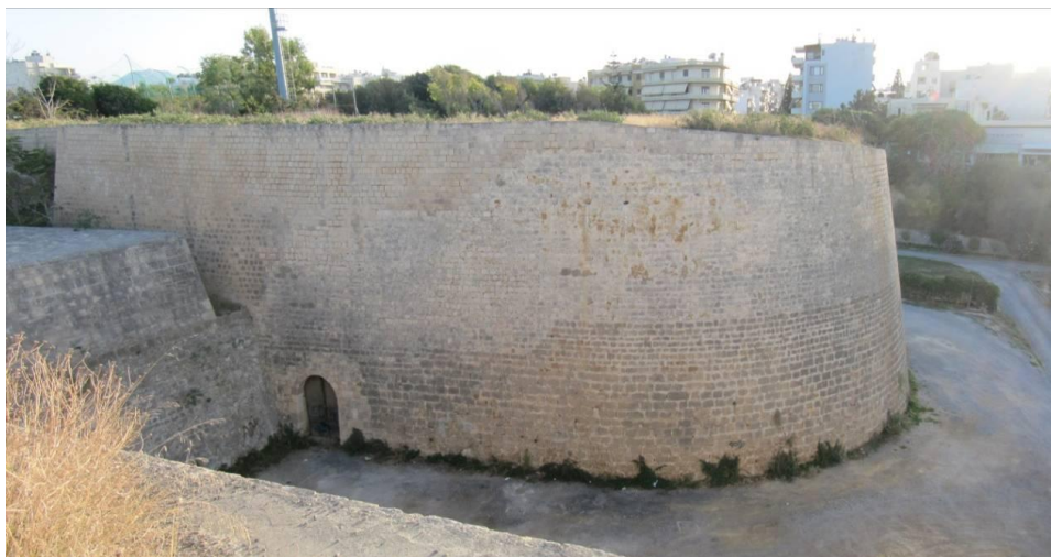
Εικόνα 5. Δυτικό ορεκίονε προμαχώνα Μαρτινέγκο. Υφιστάμενη κατάσταση. [10]
