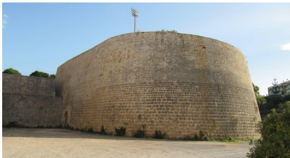
Εικόνα 6. Δυτικό ορεκίονε προμαχώνα Μαρτινέγκο. Υφιστάμενη κατάσταση. [10]
