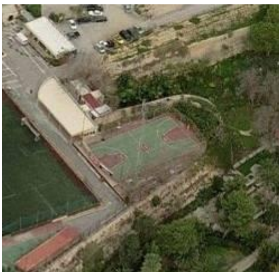
Εικόνα 27. Ανατολικό ορεκίονε προμαχώνα Μαρτινέγκο. Υφιστάμενη κατάσταση. [9]
