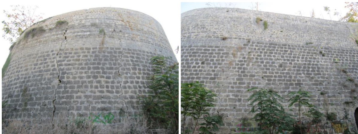
Εικόνα 26. Παθολογία ανατολικού ορεκίονε προμαχώνα Μαρτινέγκο. [10]
