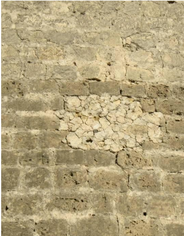
Εικόνα 23. Απώλεια λίθων και συμπλήρωμα των κενών με πολύ μικρότερους λίθους. [10]
