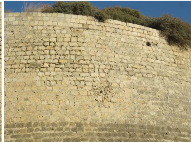
Εικόνα 25. Σπάσιμο και απώλεια λίθων, συμπλήρωμα των κενών με πολύ μικρότερους λίθους, αποσάθρωση κονιάματος και διάχυση πάνω στους λίθους. Εμφάνιση κρούστας λόγω μικροοργανισμών και ρύπανσης του αέρα. [10]
