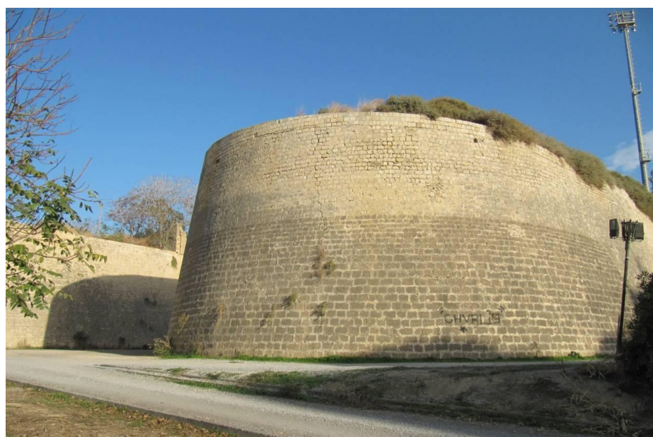
Εικόνα 7. Δυτικό ορεκίονε προμαχώνα Μαρτινέγκο. Υφιστάμενη κατάσταση. [10]
