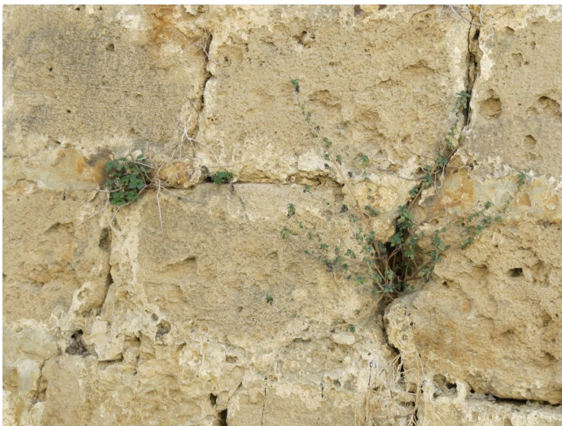
Εικόνα 17. Βλάστηση στους αρμούς μεταξύ των ασβεστόλιθων. [10]
