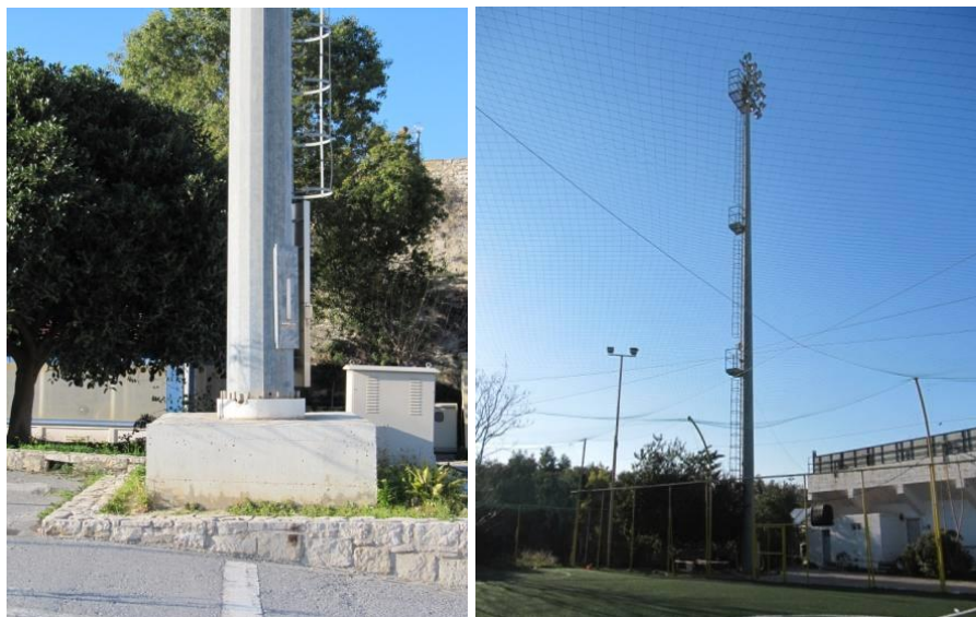
Εικόνα 34. Πυλώνες φωτισμού ΔΕΗ στον προμαχώνα Μαρτινέγκο. [10]
