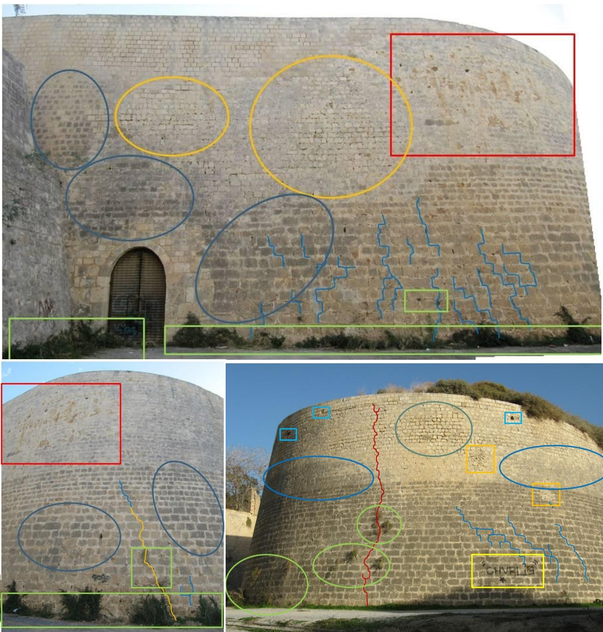
Εικόνα 15. Παθολογία δυτικού ορεκίονε προμαχώνα Μαρτινέγκο. Υφιστάμενη κατάσταση. [10]
