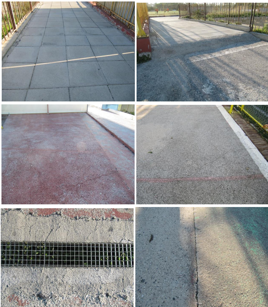
Εικόνα 14. Μη υδατοδιαπερατά υλικά επίστρωσης εδάφους. [10]
