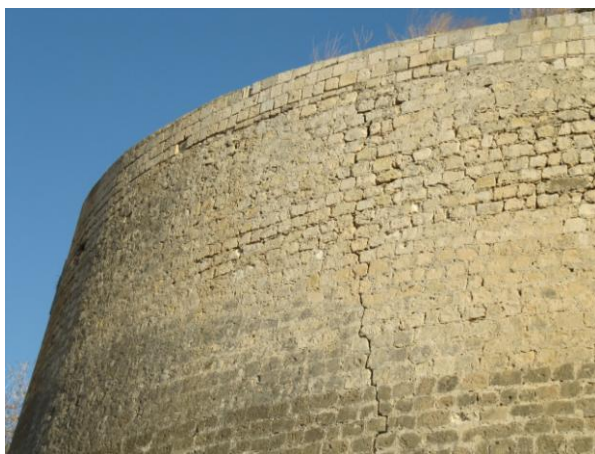
Εικόνα 25. Σπάσιμο και απώλεια λίθων, συμπλήρωμα των κενών με πολύ μικρότερους λίθους, αποσάθρωση κονιάματος και διάχυση πάνω στους λίθους. Εμφάνιση κρούστας λόγω μικροοργανισμών και ρύπανσης του αέρα. [10]
