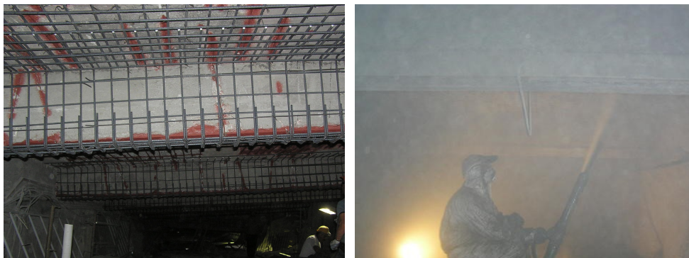
Σχήμα 14. Διαδικασία εφαρμογής μανδύα με εκτοξευόμενο σκυρόδεμα. [19]
