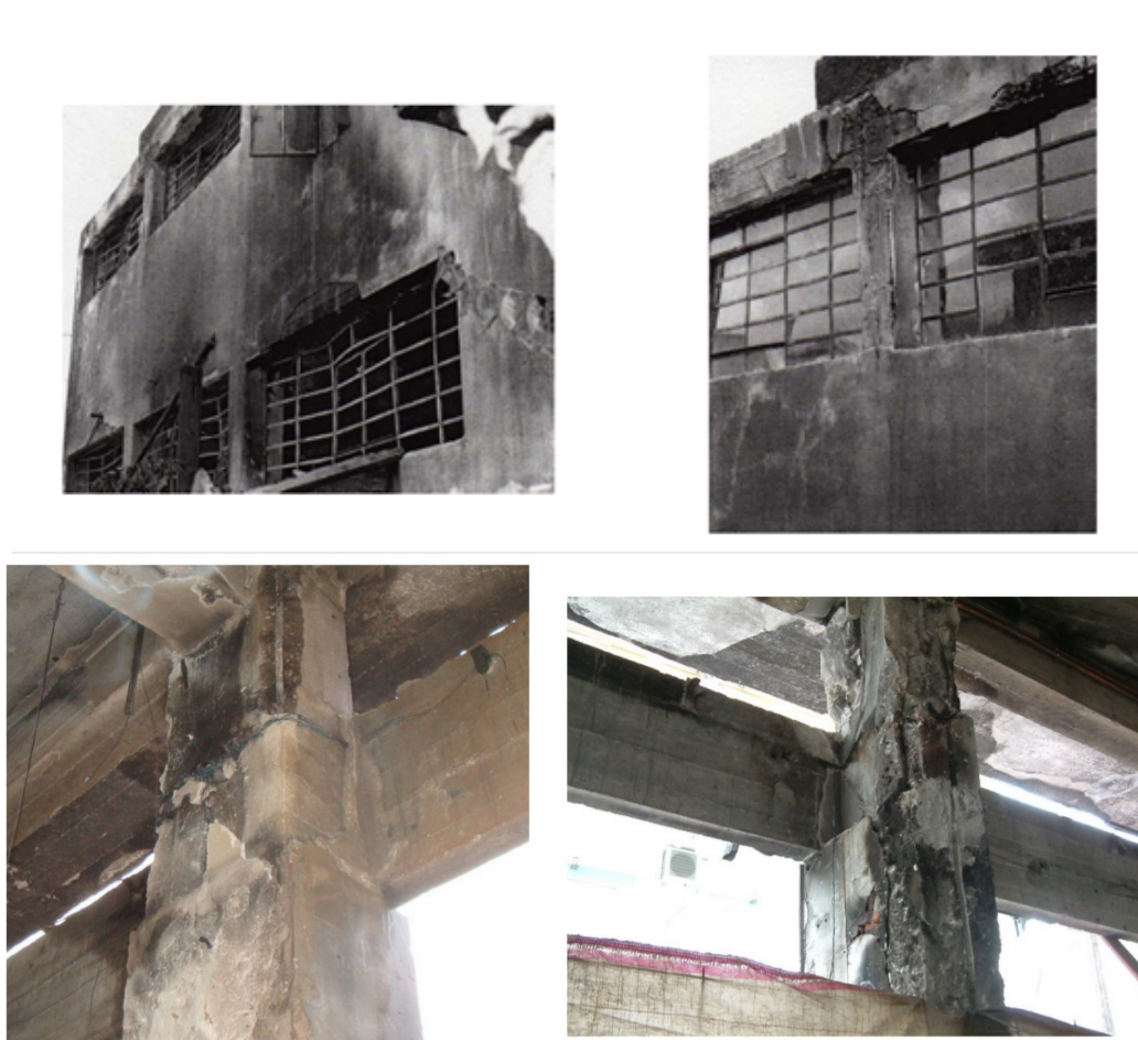
Σχήμα 7. Βλάβες ύστερα από εκδήλωση πυρκαγιάς. [13], [15]
