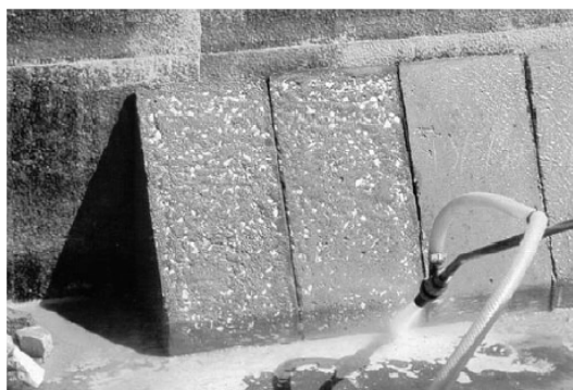
Εκτράχυνση με Αμμοβολή
