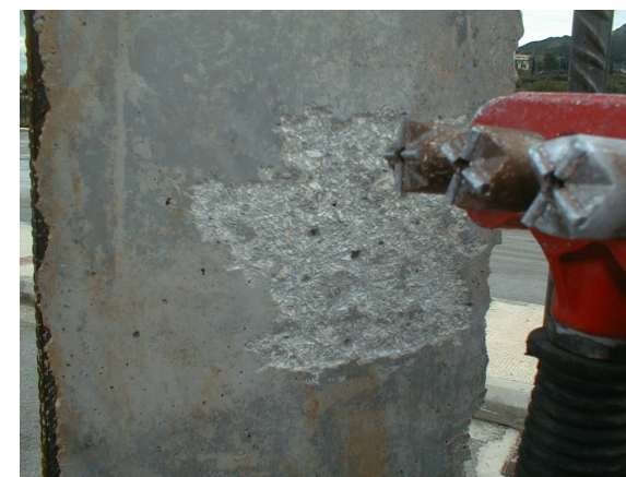
Προετοιμασία Επιφάνειας με Αεροματσάκονο
