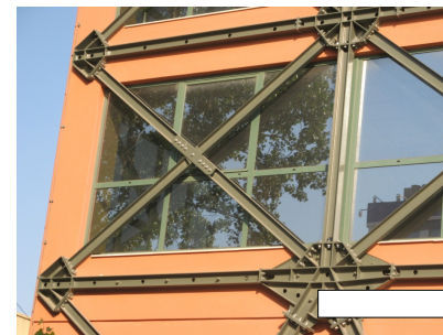
Κατασκευαστικές λεπτομέρειες σύνδεσης παράπλευρων μεταλλικών δικτυωμάτων
