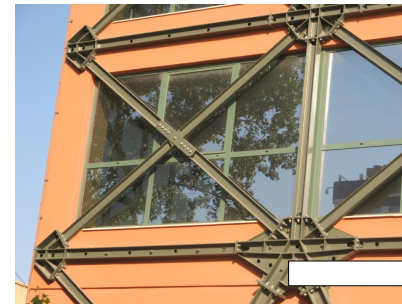
Κατασκευαστικές λεπτομέρειες σύνδεσης παράπλευρων μεταλλικών δικτυωμάτων
