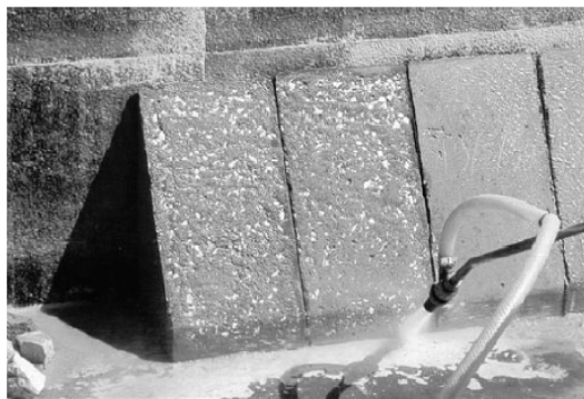
Εκτράχυνση με Αμμοβολή
