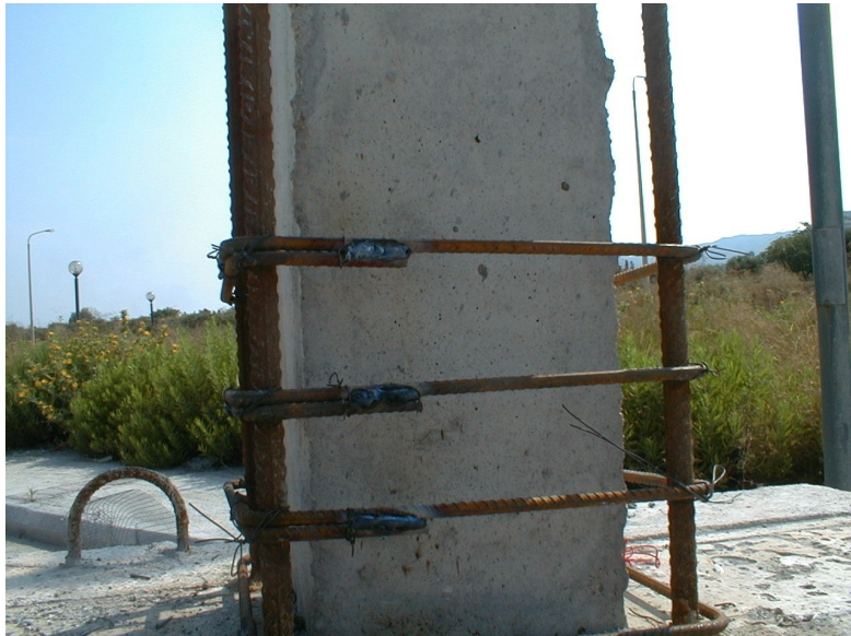
Ηλεκτροσυγκόλληση Άκρων Συνδετήρων Μανδύα
