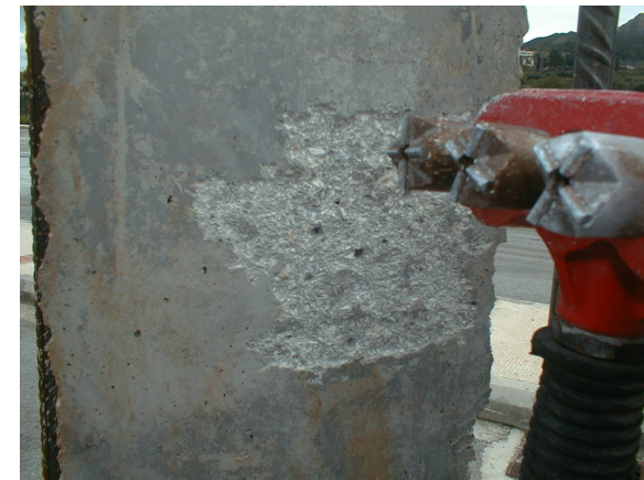
Προετοιμασία Επιφανείας με Αεροματσάκονο
