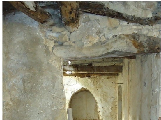
Εικόνα 21, 22: Αποσάθρωση ξύλινων στοιχείων
