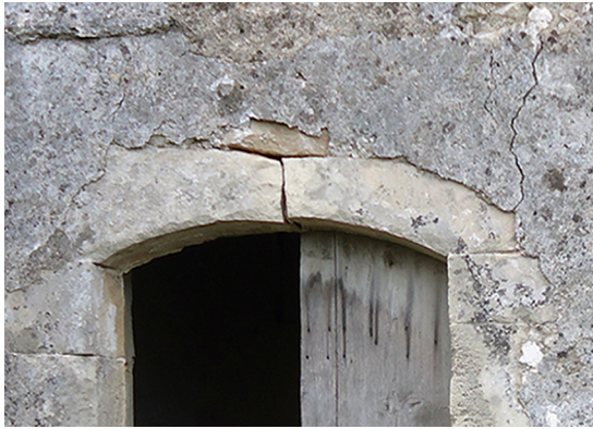
Εικόνα 19: Διαχωρισμός λίθου στο τόξο της καμάρας
