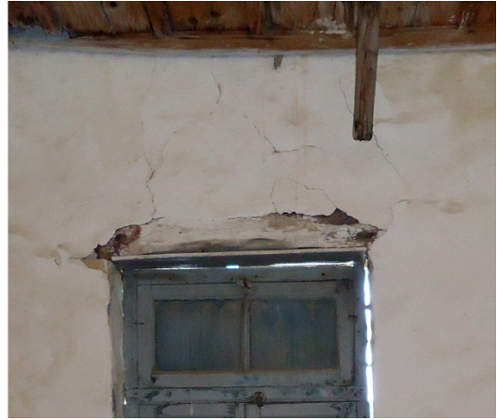
Εικόνα 17,18: Ρηγματώσεις ανοιγμάτων
