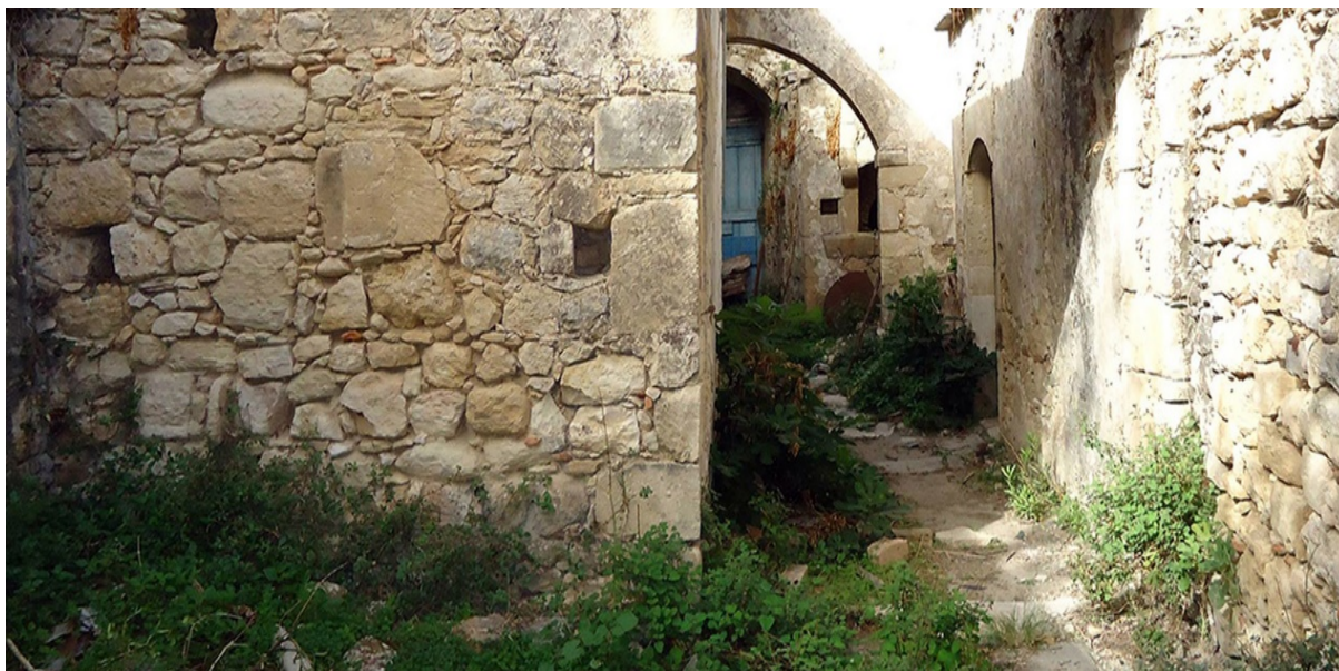
Εικόνα 32: Εμφάνιση βιολογικών μικροοργανισμών στην ανατολική όψη
