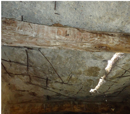
Εικόνα 28, 29: Οξείδωση χάλυβα οπλισμών
