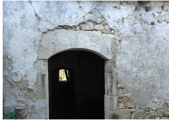
Εικόνα 20: Ρηγμάτωση τοιχοποιίας
