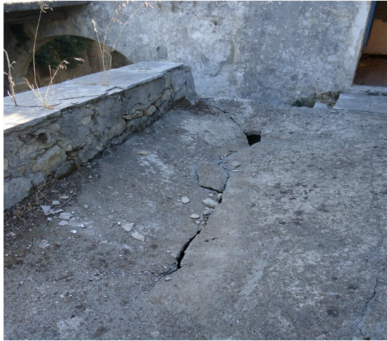
Εικόνα 26, 27: Τμηματική κατάρρευση πλάκας οπλισμένου σκυροδέματος
