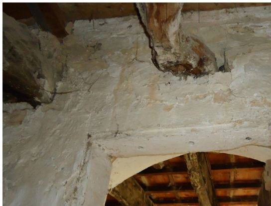
Εικόνα 21, 22: Αποσάθρωση ξύλινων στοιχείων
