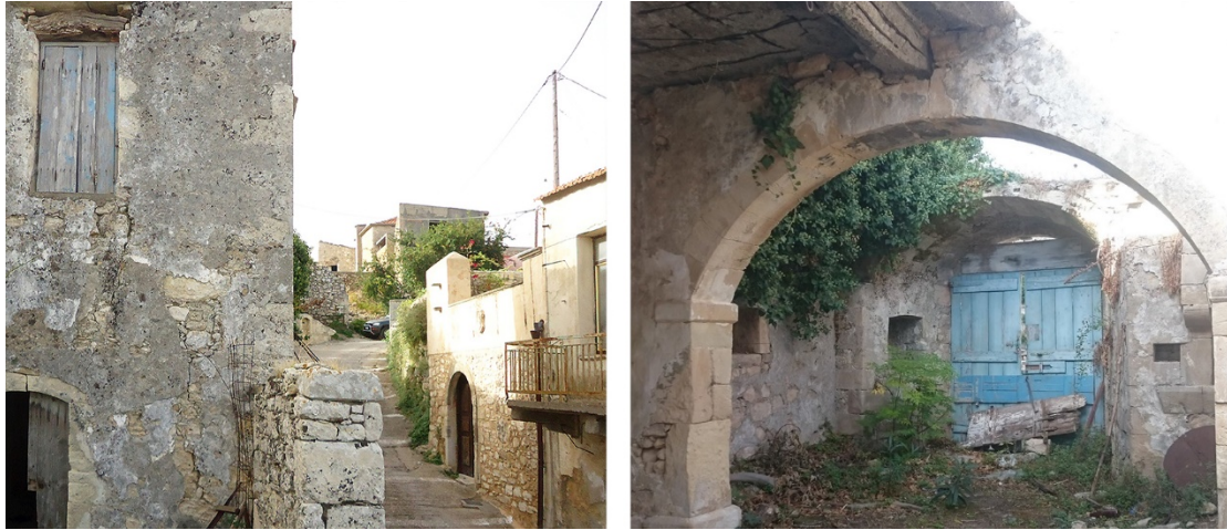
Εικόνα 8,9: Απουσία ηλιασμού λόγω υψηλού ορίου στη δυτική και νότια όψη
