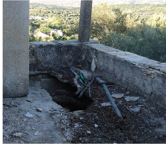
Εικόνα 26, 27: Τμηματική κατάρρευση πλάκας οπλισμένου σκυροδέματος
