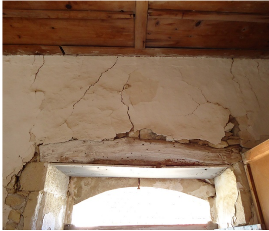
Εικόνα 17,18: Ρηγματώσεις ανοιγμάτων
