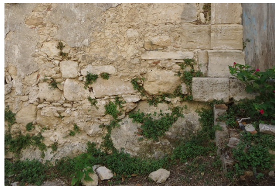
Εικόνα 30, 31: Εμφάνιση βιολογικών μικροοργανισμών στην νότια, δυτική όψη αντίστοιχα
