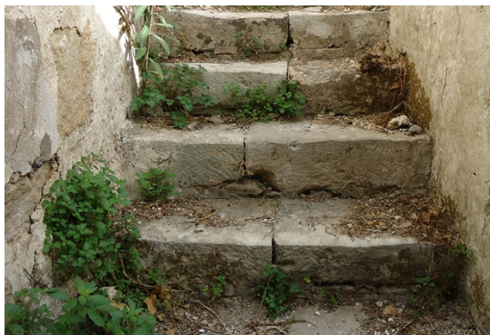
Εικόνα 30, 31: Εμφάνιση βιολογικών μικροοργανισμών στην νότια, δυτική όψη αντίστοιχα
