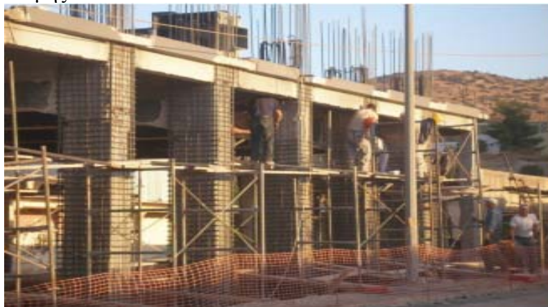
Σχήμα 5.4: Τοποθέτηση μανδυών οπλισμένου σκυροδέματος-Σ. Δρίτσος «Ενισχύσεις-Επισκευές»[6]
