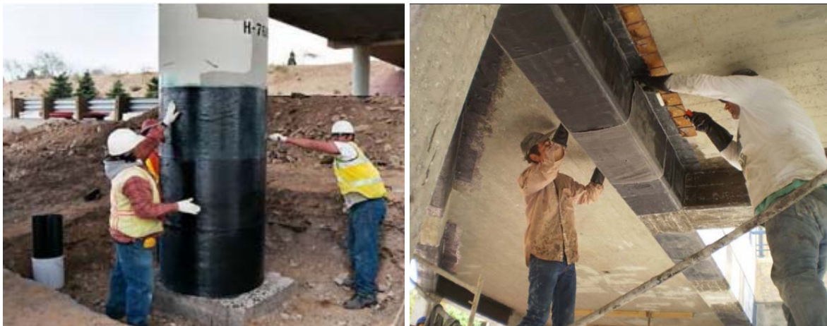
Σχήμα 5.1: Τοποθέτηση μανδύων ινοπλισμένων πολυμερών-Σ. Δρίτσος «Ενισχύσεις-Επισκευές»[6]
