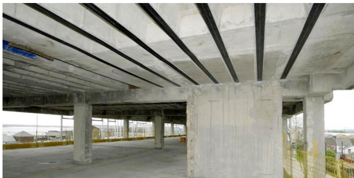
Εικόνα 2: Λωρίδες (Strips) από FRP
