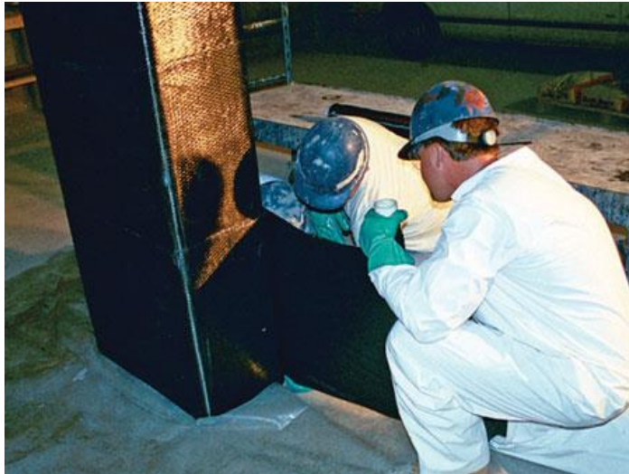
Εικόνα 1: Συνεχή υφάσματα (Sheets) από FRP
