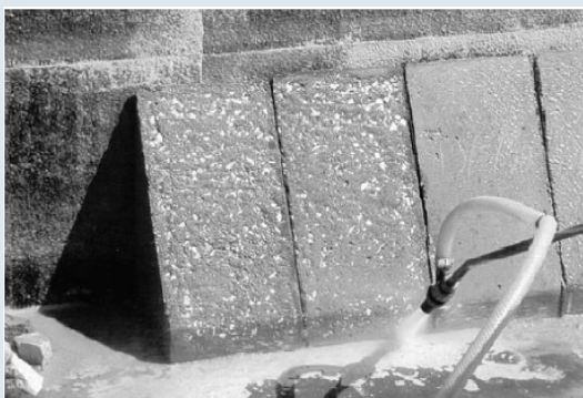
Εκτράχυνση με Αμμοβολή
