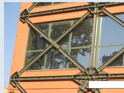
Κατασκευαστικές λεπτομέρειες σύνδεσης παράπλευρων μεταλλικών δικτυωμάτων
