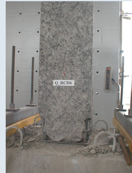
Βλάβες σε Δοκίμιο με Εκτοξευόμενο Σκυρόδεμα και Βλήτρα
