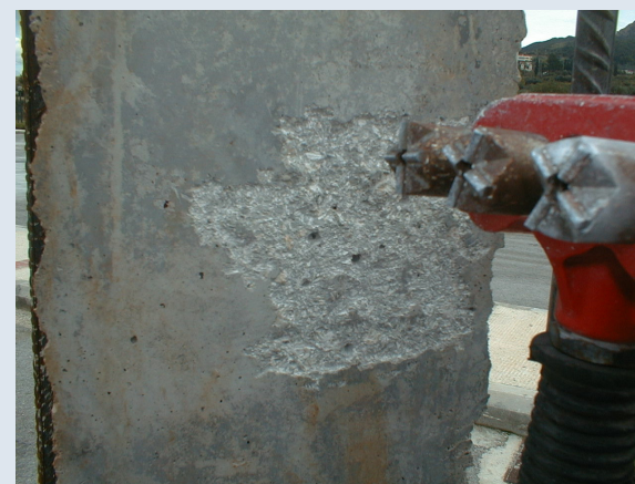
Προετοιμασία Επιφάνειας με Αεροματσάκονο
