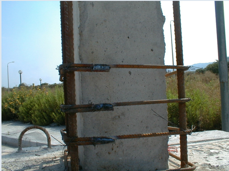
Ηλεκτροσυγκόλληση Άκρων Συνδετήρων Μανδύα 19
