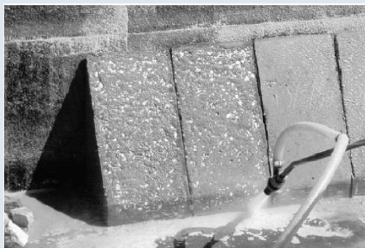
Εκτράχυνση με Αμμοβολή
