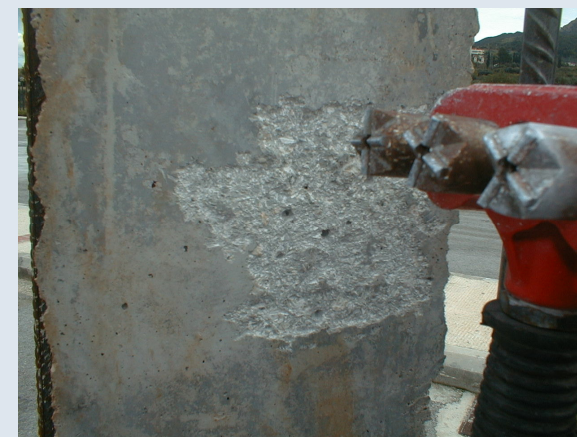
Προετοιμασία Επιφάνειας με Αεροματσάκονο
