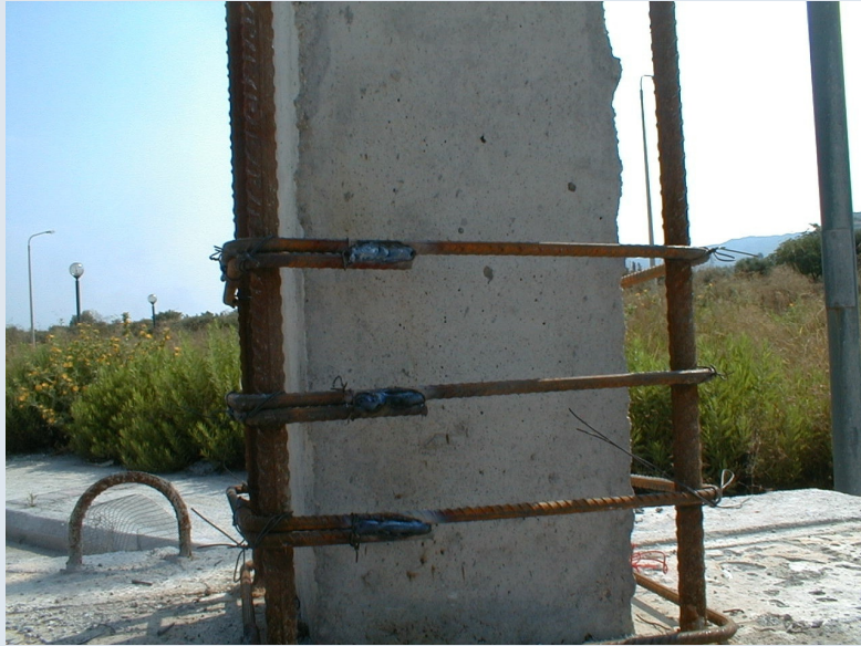
Ηλεκτροσυγκόλληση Άκρων Συνδετήρων Μανδύα 53
