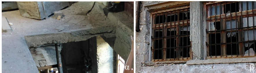
Εικόνα 8: Ρηγματώσεις και αποκόλληση της επικάλυψης οπλισμού της πλάκας (α), αποκόλληση της επικάλυψης και αποκάλυψη οπλισμών στα πρέκια και στα υποστυλώματα (β) της ανατολικής όψης
