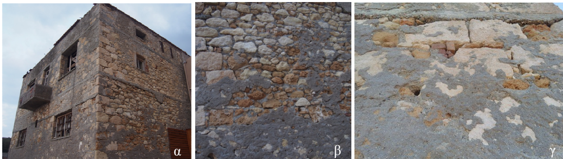
Εικόνα 4: Αποκόλληση κονιάματος στη δυτική όψη (α), λεπτομέρειες της όψης (β,γ)
