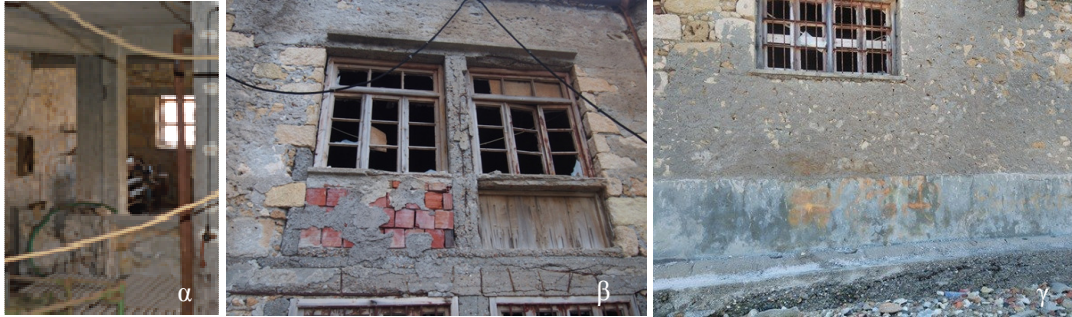
Εικόνα 11: Ενίσχυση με προσθήκη υποστυλώματος (α), αντικατάσταση λίθων με τούβλα ή και ξύλινα στοιχεία (β), τοποθέτηση τσιμεντοκονιάματος (γ)
