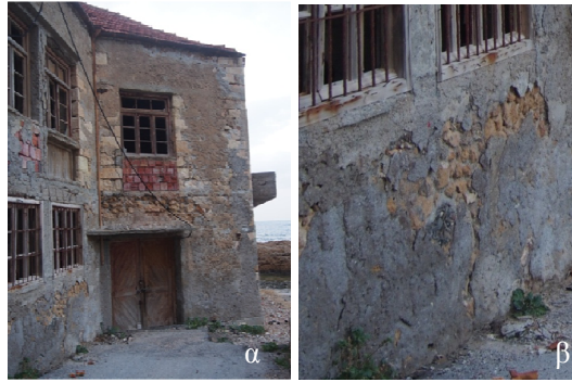
Εικόνα 5: Αποκολλήσεις και ρηγματώσεις στο κονίαμα επιχρίσματος στην ανατολική όψη (α,β)
