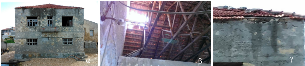
Εικόνα 10: Βλάβες στέγης διακριτές στη βόρεια όψη (α), αστοχία ζευκτού στέγης στο νότιο τμήμα του κτιρίου (β), οριζόντια ρηγμάτωση της φέρουσας τοιχοποιίας στο ύψος της στέγης (γ)
