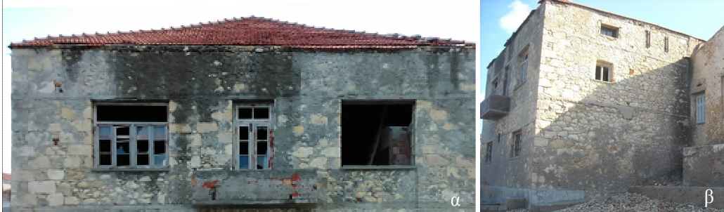
Εικόνα 7: Μάυρες κρούστες στη βόρεια (α) και δυτική όψη (β)
