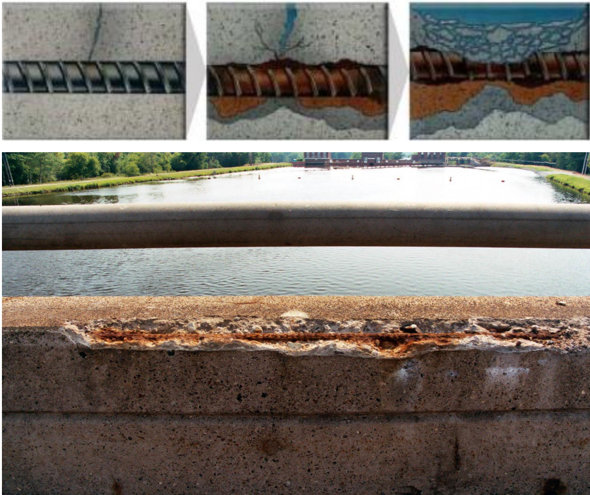
Σχ. 3: Διάβρωση Οπλισμού
