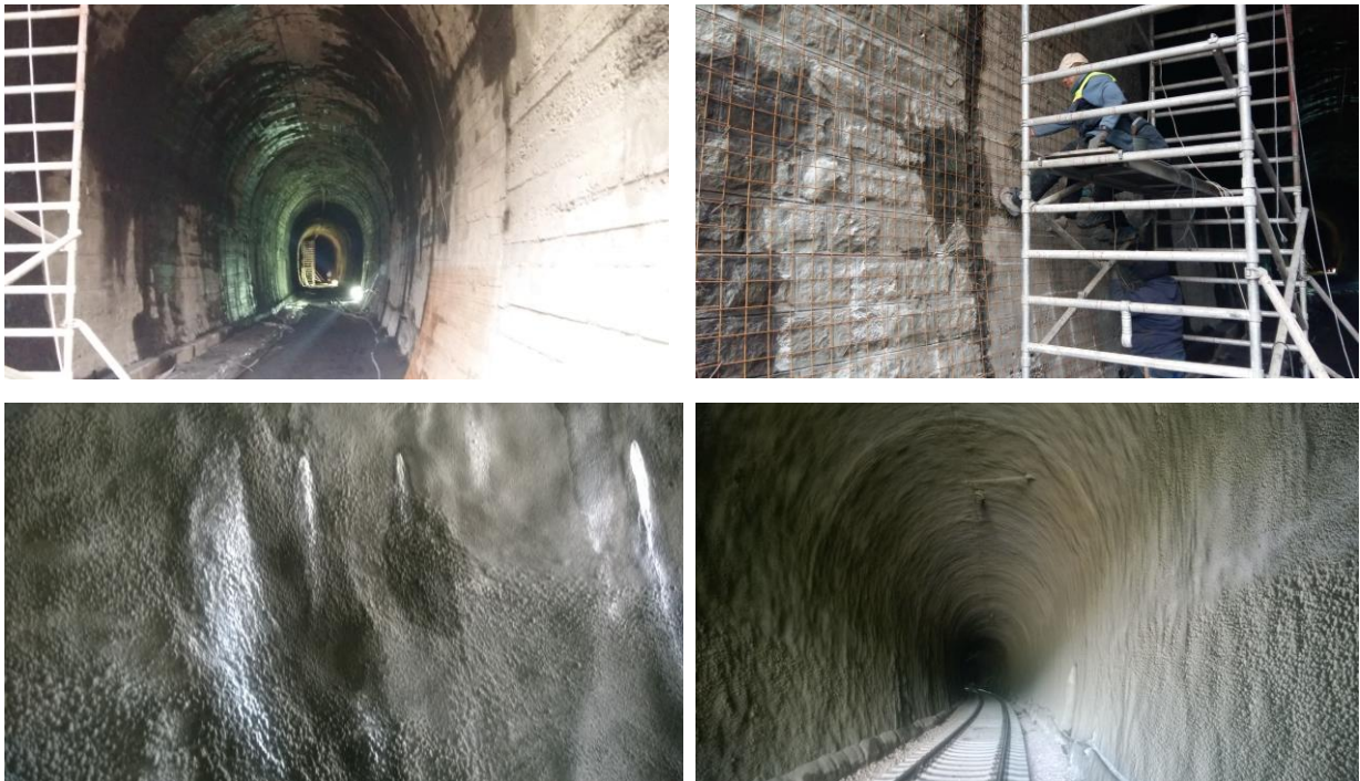
Σχ. 21: Στεγανοποίηση Τούνελ με εκτοξευόμενο σκυρόδεμα [15]
