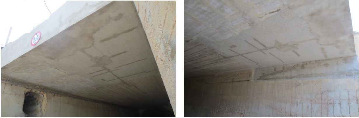
Σχ. 18: Επισκευή Οχετών Εθνικής Οδού Κορίνθου Πατρών [12]
