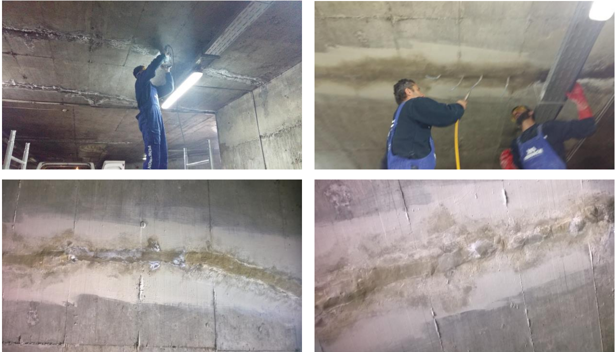
Σχ. 20: Στεγανοποίηση Διαφραγματικών Τοίχων Μετρό Βουλγαρίας με ενέματα PENETRON® INJECT [10]
