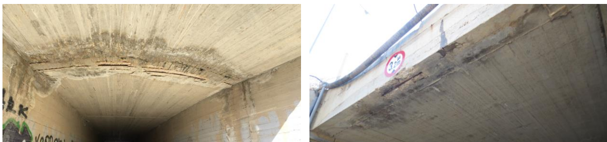
Σχ. 17: Επισκευή Οχετών Εθνικής Οδού Κορίνθου Πατρών [12]
