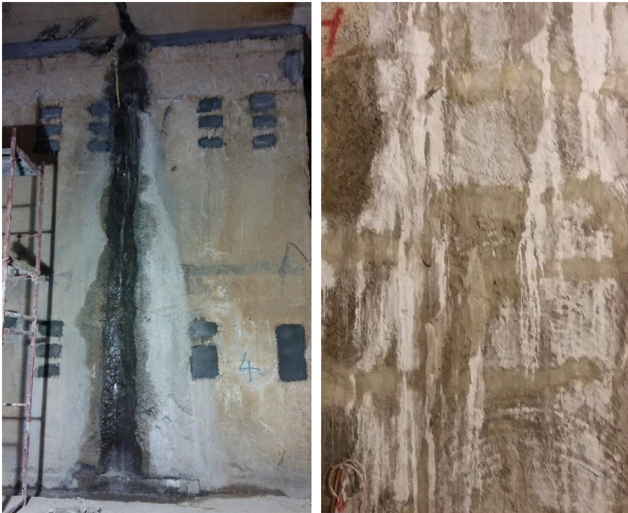
Σχ. 19: Στεγανοποίηση Διαφραγματικών Τοίχων Μετρό Θεσσαλονίκης [11]
