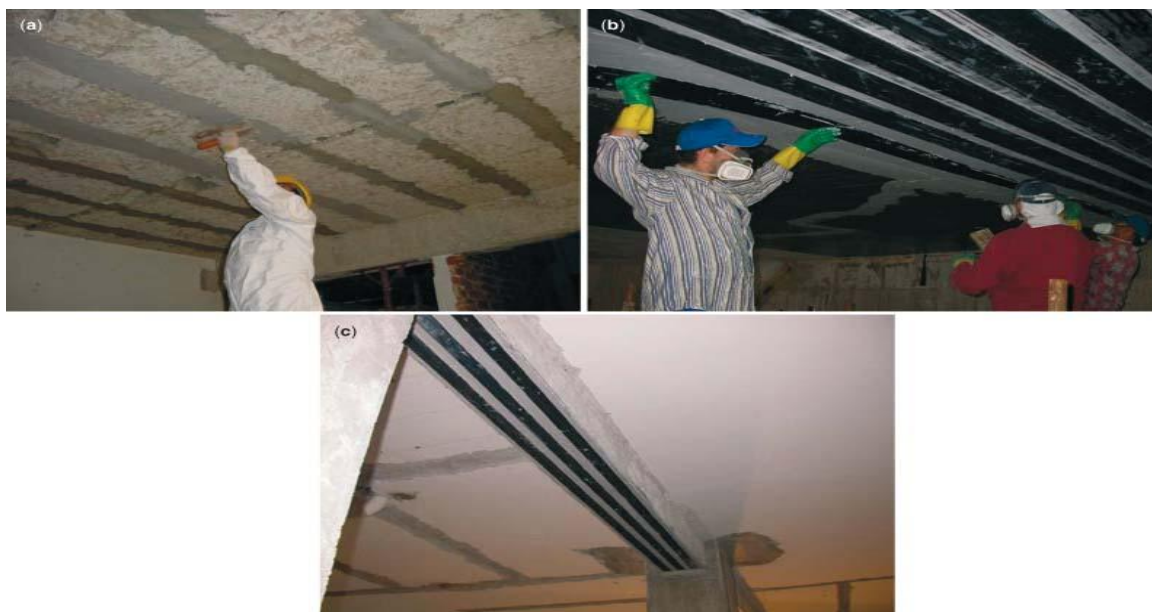
Εικόνα 19 : (a) Επάλειψη επιφάνειας με εποξική ρητίνη , (b) Τοποθέτηση στρώσεων του ανοπλισμένου πολυμερούς [19]
