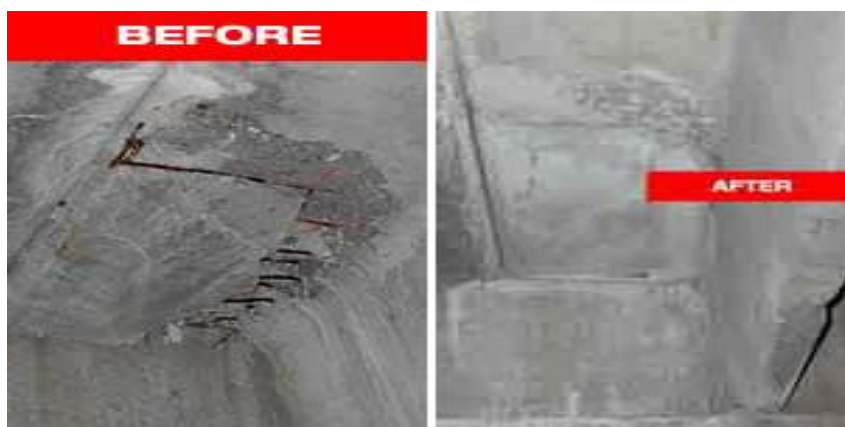
Εικόνα 18 : Επιδιόρθωση ρωγμών με ρητινενέσεις - προετοιμασία επιφάνειας [18]
