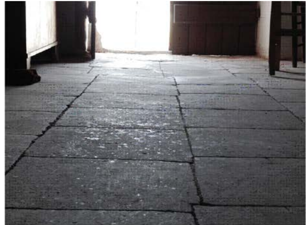
Εικόνα 11: Ανισοσταθμία δαπέδου
