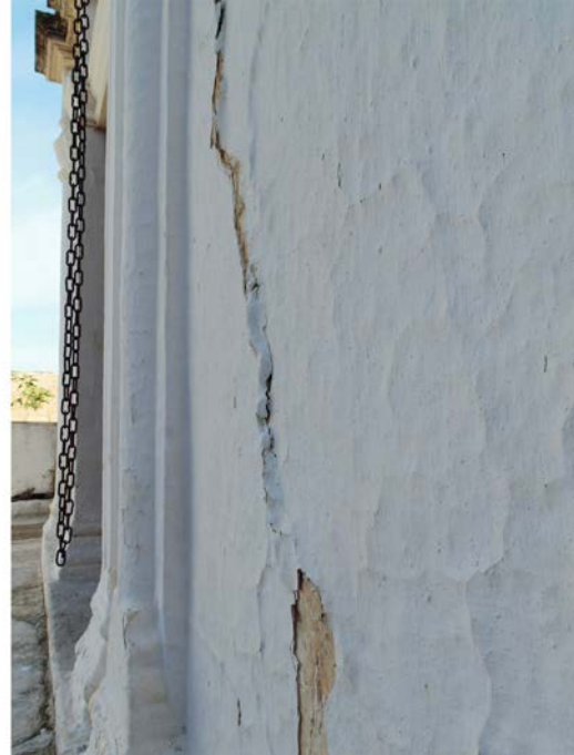
Εικόνα 12: Ρηγματώσεις στην δυτική όψη Εικόνα 13: Αποκόλληση επιχρίσματος
