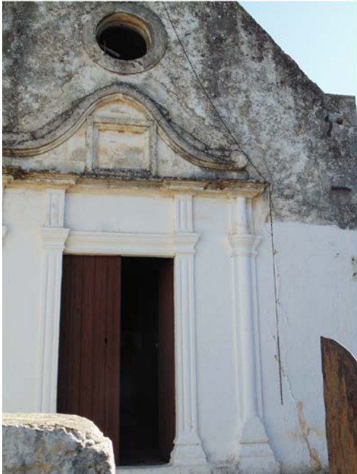
Εικόνα 12: Ρηγματώσεις στην δυτική όψη Εικόνα 13: Αποκόλληση επιχρίσματος
