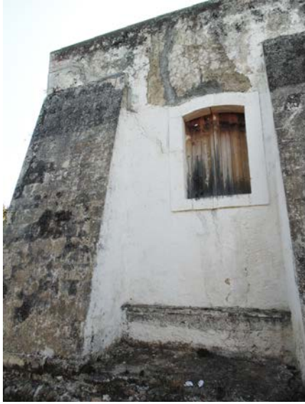
Εικόνα 4: Διαμετρής ρωγμή στην εξωτερική βόρεια όψη
