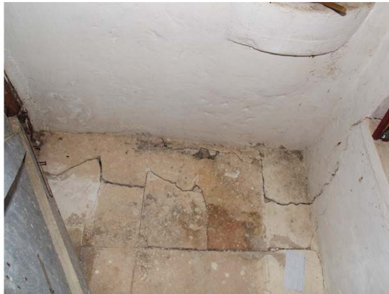
Εικόνα 7: Ρωγμές στο δάπεδο του ιερού
