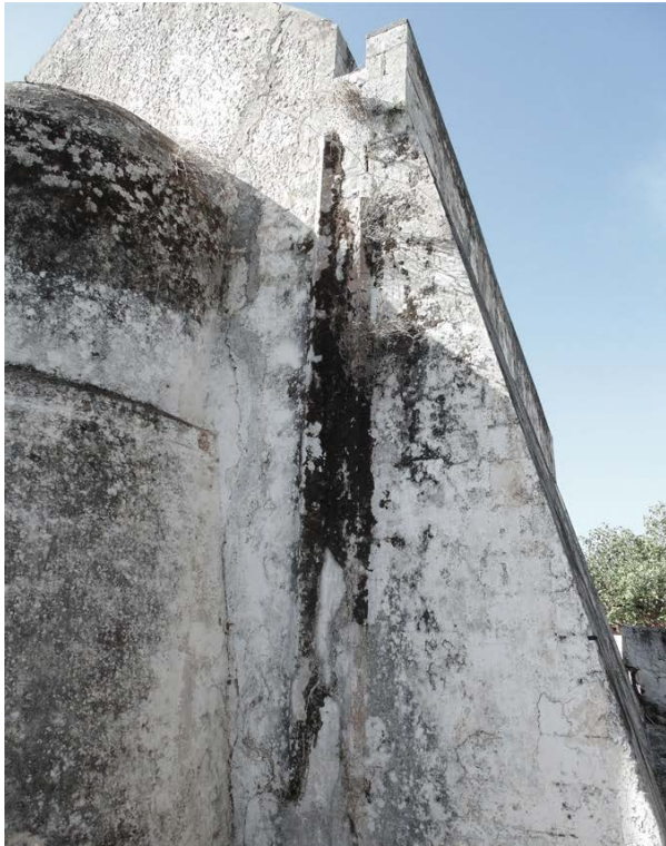
Εικόνα 8: Εμφάνιση έντονης υγρασίας
