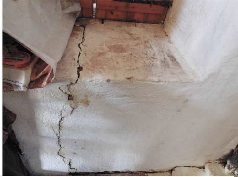
Εικόνα 5: Διαμετρής ρωγμή στην εσωτερική βόρεια όψη
