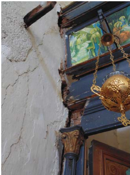
Εικόνα 6: Εμφάνιση έντονης υγρασίας
