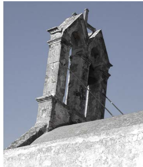
Εικόνα 15: Επικλινείς μεταλλικές ράβδοι για στήριξη
