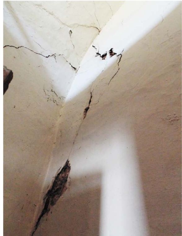
Εικόνα 9: Μερική πτώση επιχρίσματος
