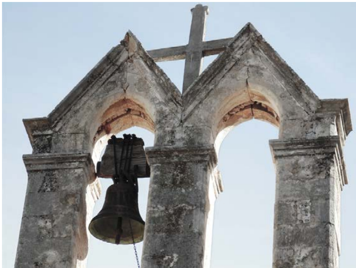
Εικόνα 14: Ρηγματώσεις και αποκολλήσεις στο καμπαναριό
