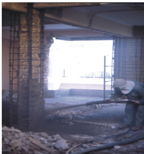
Εκτόξευση Μανδύα Υποστρώματος
