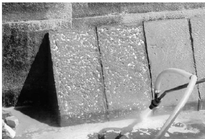
Εκτράχυνση με Αμμοβολή
