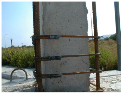
Ηλεκτροσυγκόλληση Άκρων Συνδετήρων Μανδύα
