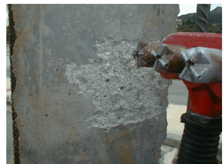
Προετοιμασία Επιφάνειας με Αεροματσάκονο
