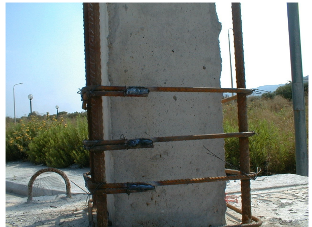
Ηλεκτροσυγκόλληση Άκρων Συνδετήρων Μανδύα
