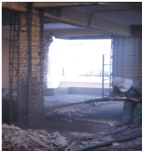
Εκτόξευση Μανδύα Υποστυλώματος
