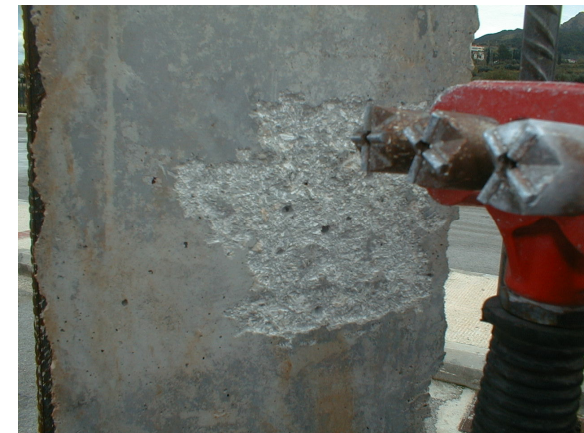
Προετοιμασία Επιφάνειας με Αεροματσάκονο
