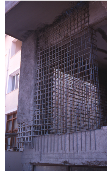
Προσθήκη πτερυγίων σε συνέχεια υποστυλωμάτων με σύγχρονη κατασκευή μανδύα σε υποστύλωμα
