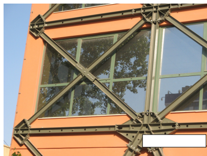
Κατασκευαστικές λεπτομέρειες σύνδεσης παράπλευρων μεταλλικών δικτυωμάτων
