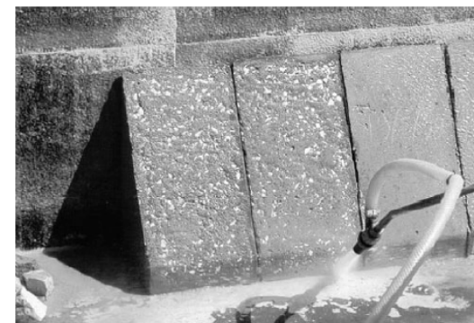
Εκτράχυνση με Αμμοβολή
