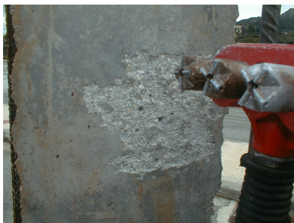
Προετοιμασία Επιφάνειας με Αεροματσάκονο
