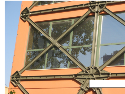
Κατασκευαστικές λεπτομέρειες σύνδεσης παράπλευρων μεταλλικών δικτυωμάτων
