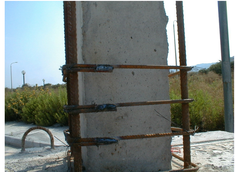
Ηλεκτροσυγκόλληση Άκρων Συνδετήρων Μανδύα
