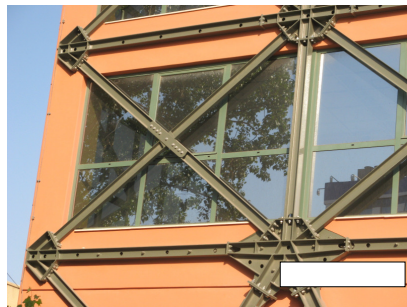
Κατασκευαστικές λεπτομέρειες σύνδεσης παράπλευρων μεταλλικών δικτυωμάτων
