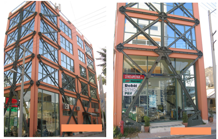
Προσθήκη παράπλευρων εξωτερικών μεταλλικών συστημάτων
