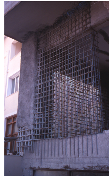
Προσθήκη πτερυγίων σε συνέχεια υποστυλωμάτων με σύγχρονη κατασκευή μανδύα σε υποστυλώμα
