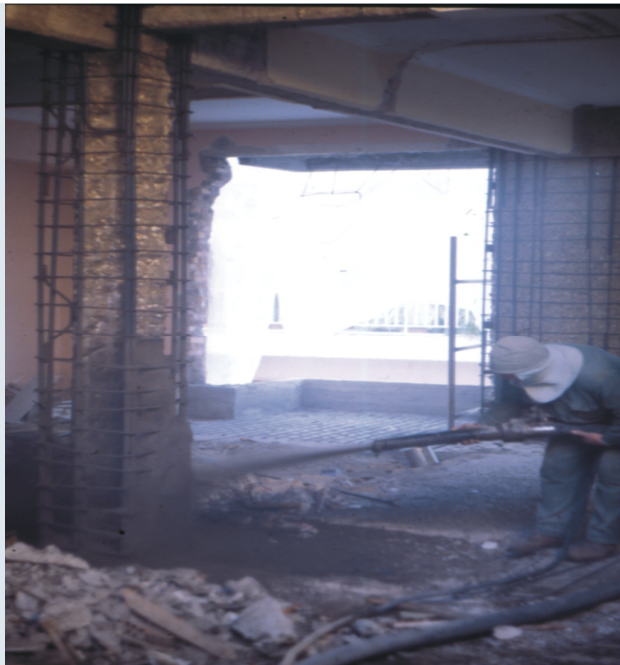
Εκτόξευση Μανδύα Υποστυλώματος
