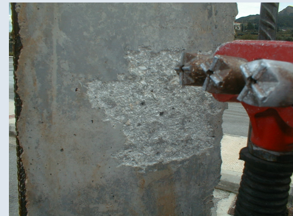
Προετοιμασία Επιφάνειας με Αεροματσάκονο
