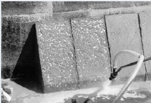
Εκτράχυνση με Αμμοβολή
