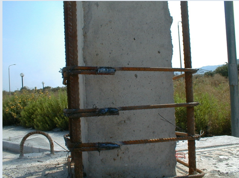
Ηλεκτροσυγκόλληση Άκρων Συνδετήρων Μανδύα 23
