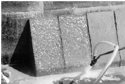
Εκτράχυνση με Αμμοβολή
