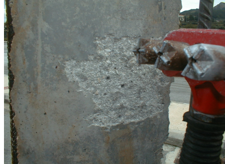
Προετοιμασία Επιφάνειας με Αεροματσάκονο
