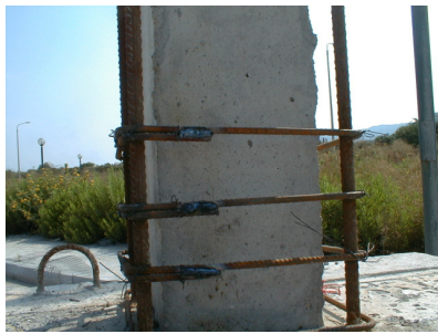
Ηλεκτροσυγκόλληση Άκρων Συνδετήρων Μανδύα
