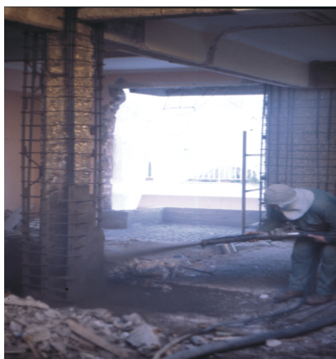
Εκτόξευση Μανδύα Υποστυλώματος
