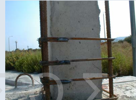
Ηλεκτροσυγκόλληση Άκρων Συνδετήρων Μανδύα
