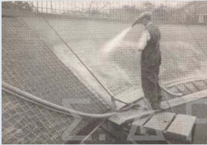
Εκτόξευση σκυροδέματος το 1919 για κατασκευή δεξαμενής νερού
