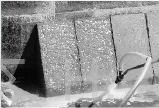
Εκτράχυνση με Αμμοβολή
