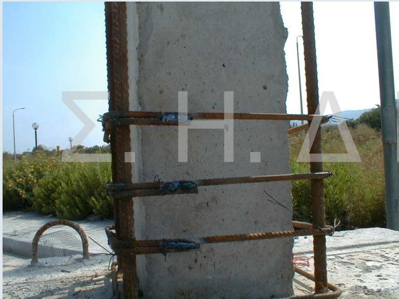
Ηλεκτροσυγκόλληση Άκρων Συνδετήρων Μανδύα 75
