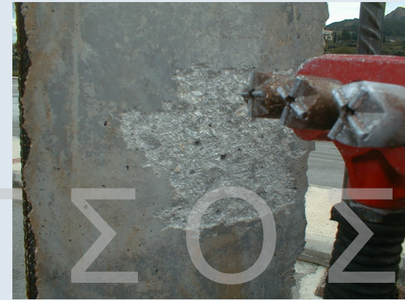
Προετοιμασία Επιφάνειας με Αεροματσάκονο
