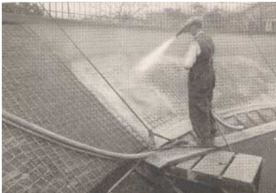
Σχήμα 3.4: Εκτόξευση σκυροδέματος το 1919 για κατασκευή δεξαμενής νερού (Yoggy, 2000)
