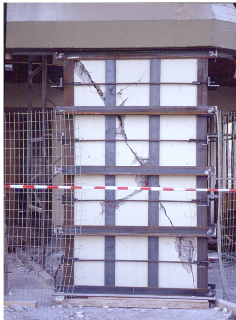
Σχήμα 5.10: Επέμβαση με μεταλλικό κλωβό για προσωρινή ανάληψη κατακόρυφων φορτίων
