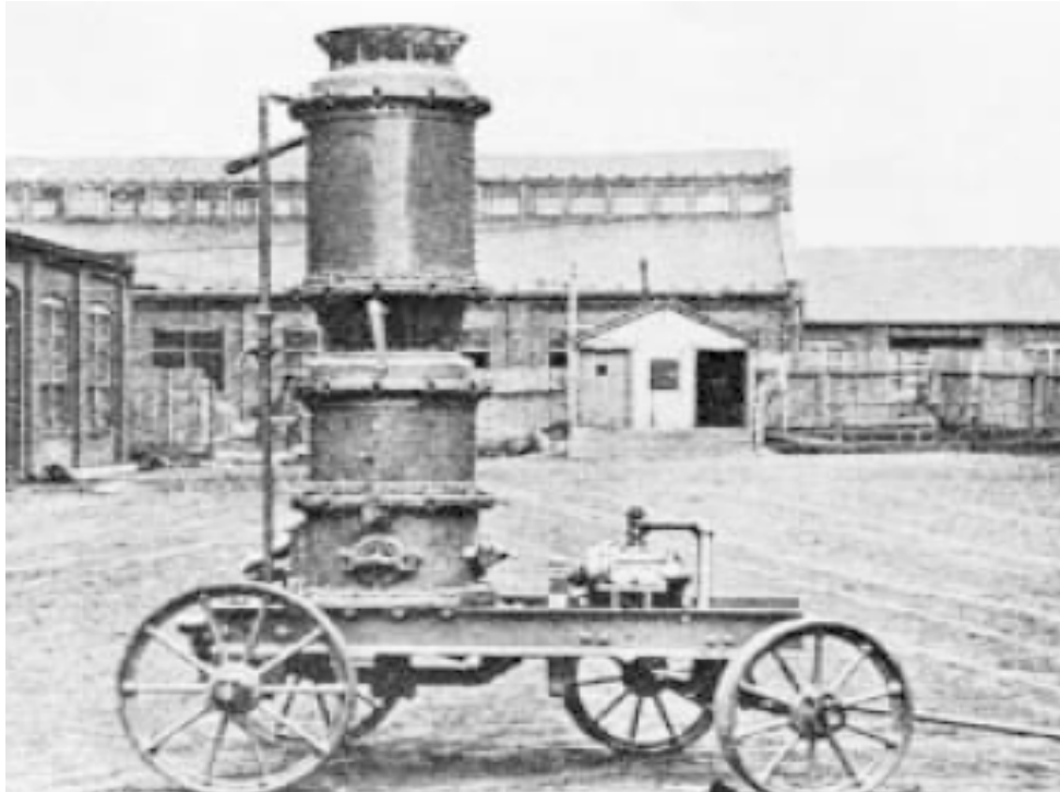
Σχήμα 3.1: Η πρώτη μηχανή εκτοξευόμενου σκυροδέματος που χρησιμοποιήθηκε από τον Carl Akeley το 1907 (φωτογραφία του J.J. Shideler, Portland Cement Association) (Teichert, 2002)
