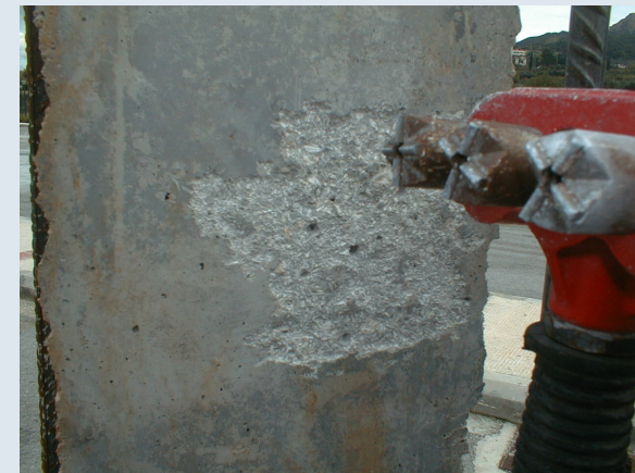
Προετοιμασία Επιφάνειας με Αεροματσάκονο
