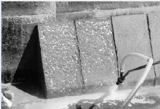
Εκτράχυνση με Αμμοβολή
