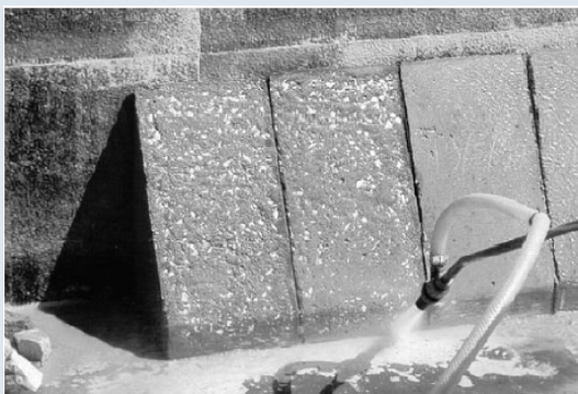
Εκτράχυνση με Αμμοβολή
