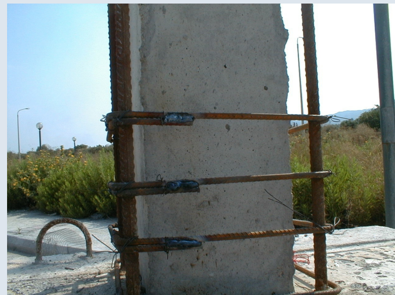
Ηλεκτροσυγκόλληση Άκρων Συνδετήρων Μανδύα
