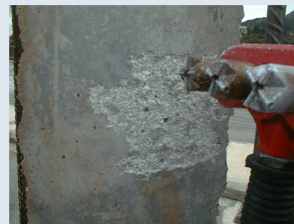
Προετοιμασία Επιφάνειας με Αεροματσάκονο
