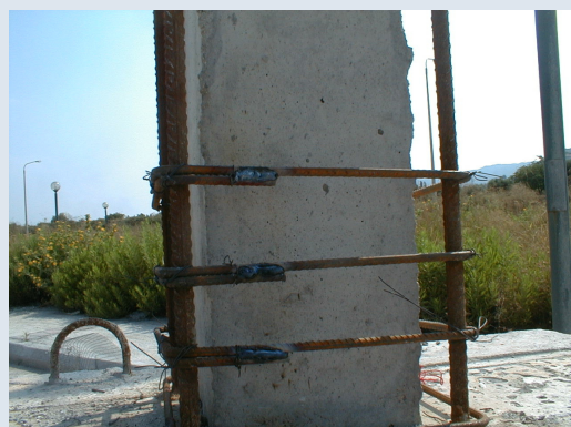
Ηλεκτροσυγκόλληση Άκρων Συνδετήρων Μανδύα
