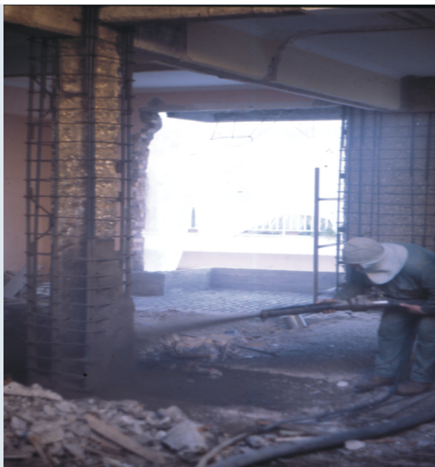
Εκτόξευση Μανδύα Υποστυλώματος
