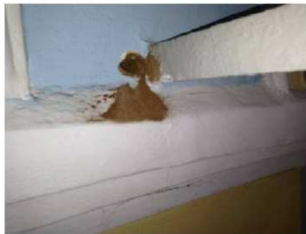
Εργασίες διερεύνησης μήκους αγκύρωσης ελκυστήρων
