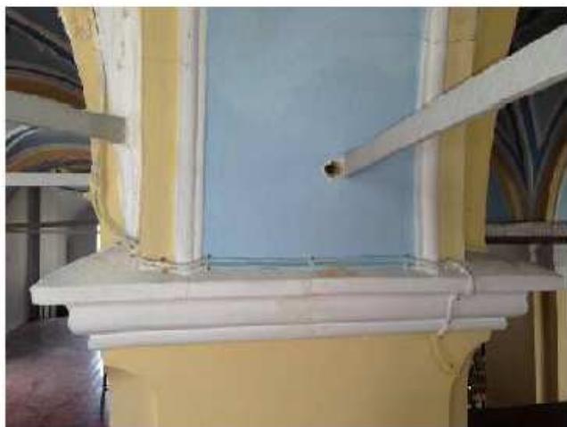
Εργασίες διερεύνησης μήκους αγκύρωσης ελκυστήρων
