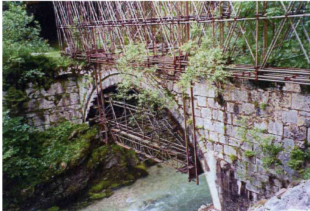
Pont du Grand Logis (18th cent.) Προσωρινή στήριξη με ανάρτηση
